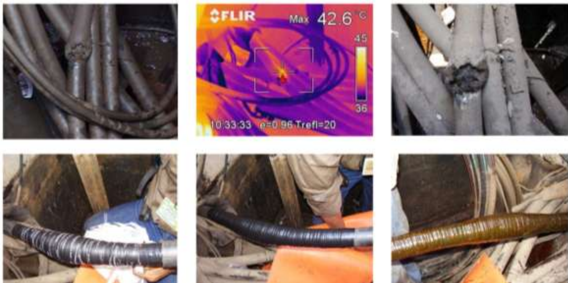
Figura 3. Reparación Cable del Enlace AL004/U2400
