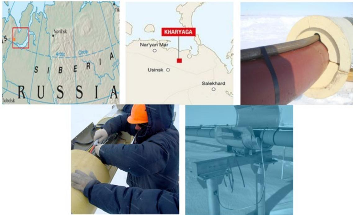
En el campo Kharyaga las condiciones ambientales alcanzan temperaturas invernales de  $-46^{\circ}\text{C}$ . Sin embargo, a través de sistemas de calentamiento eléctrico por tecnología de efecto piel se logra desde un solo punto de suministro eléctrico mantener el fluido a temperaturas de  $40^{\circ}\text{C}$  a lo largo de secciones de 10Km, asegurando la fluidez de la producción.
