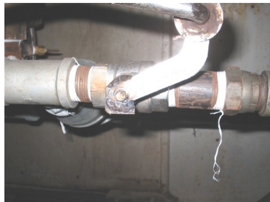
Fig. 38: Control de los carreteles
