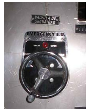
Fig. 2 Control de la Válvula de alivio.
