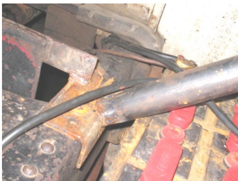
Fig. 34: Soporte de la descarga
