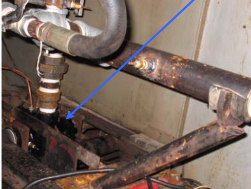
Fig. 44: Bomba en su sitio
