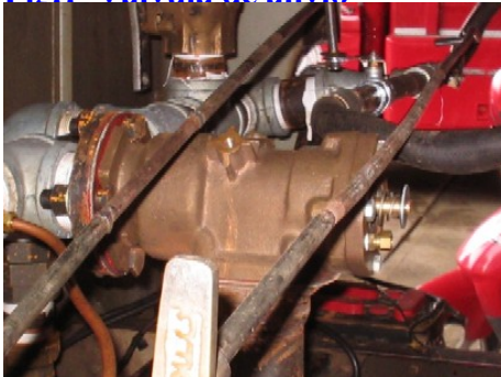
Fig.1 Válvula de alivio
