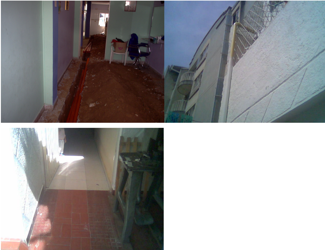
Foto 3. Construcción intradomiciliaria de aguas lluvias, Delicias Bajas.
