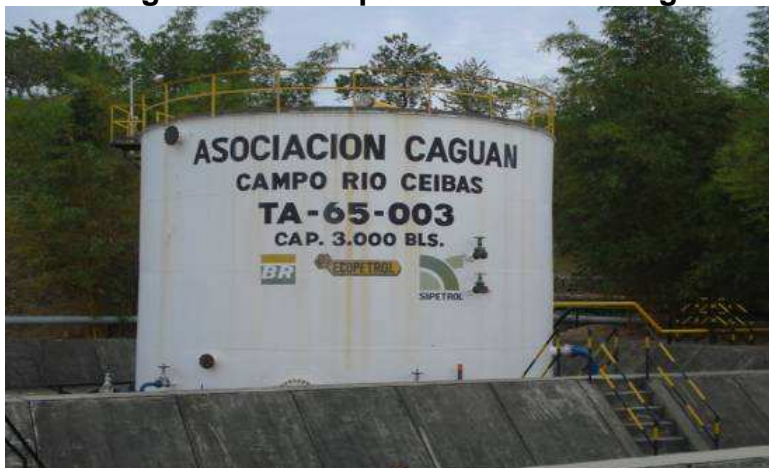
Fotografía 11. Tanque clarificador de agua
