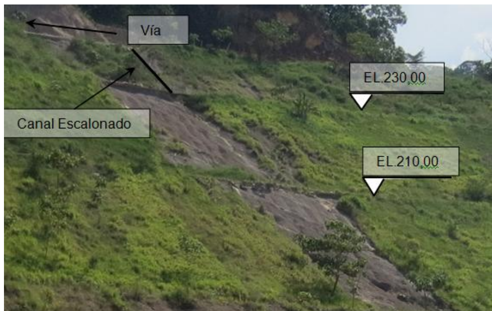
Fotografía 9. Detalle de drenajes en la parte superior del cuenco
