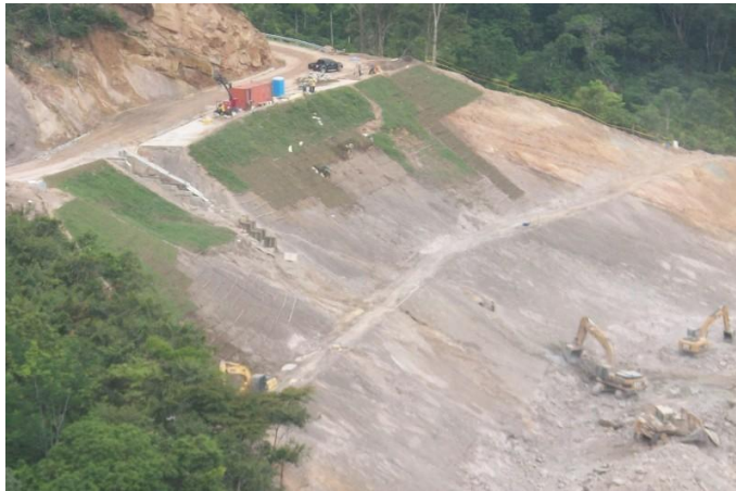
Fotografía 5 . Trabajos iniciales de excavación y protección del talud
