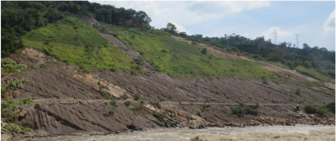
Fotografía 7. Estado actual del talud
