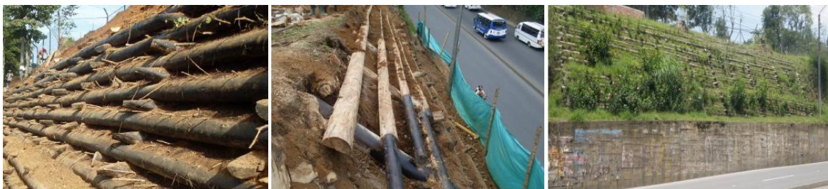
Construcción de entramados
