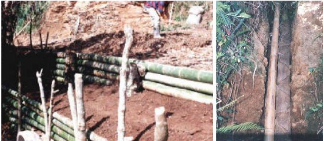
Fotografía 3. Terrazas escalonadas en tierra y filtro de guadua
