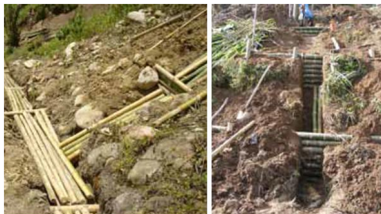
Fotografía 1. Filtros vivos de guadua
