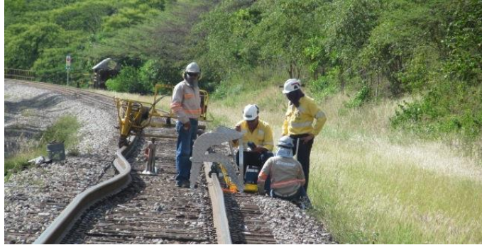
Figura 3. Mantenimiento con herramientas manuales en la vía de la mina.
