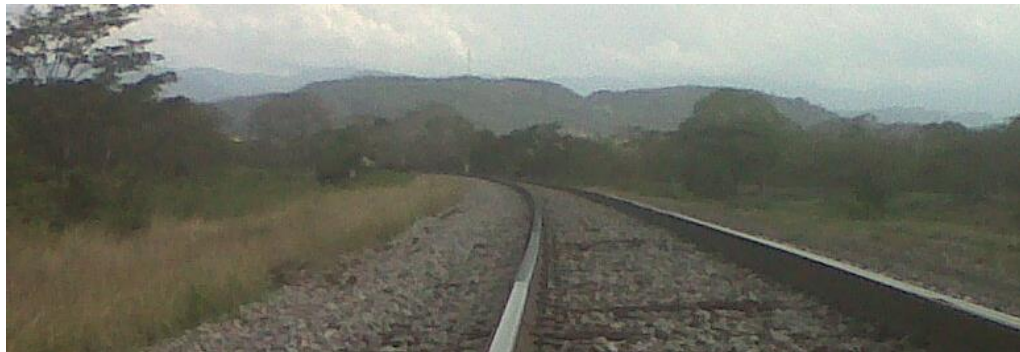
Figura 20. Fotografía de la vía de la empresa minera.
