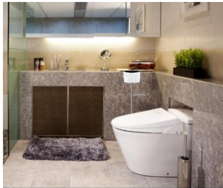
Figura 56. Bidet electrónico DB8500 instalado
