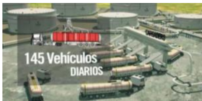
Figura 22. Cargadero de crudo.
