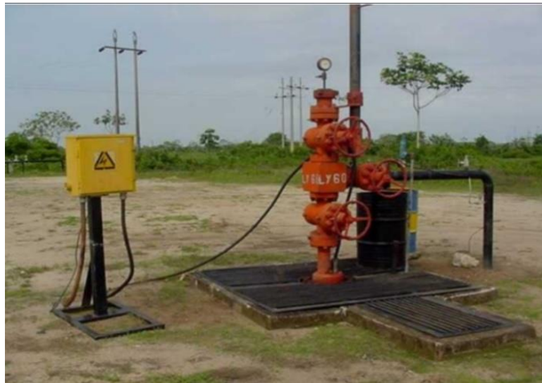
Figura 12. Cabezal de pozo.
