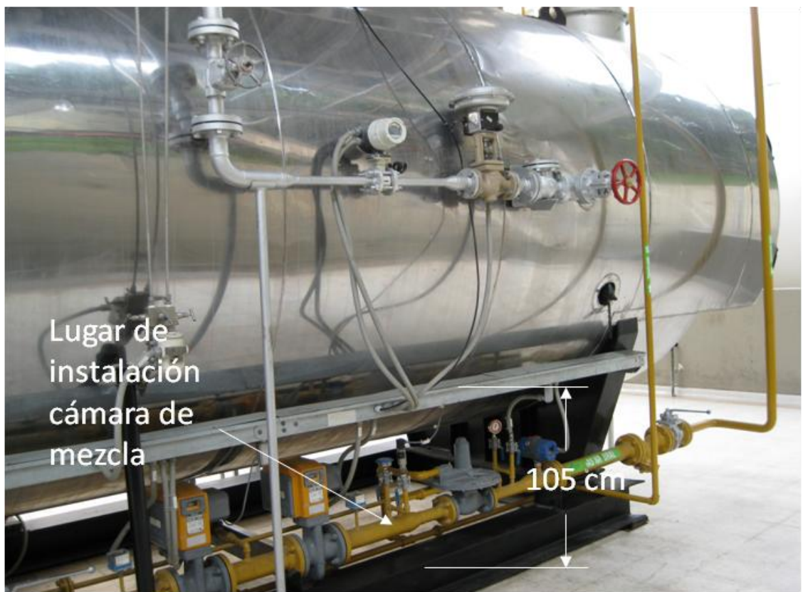
Figra 45. Lugar de instalación cámara de mezcla
