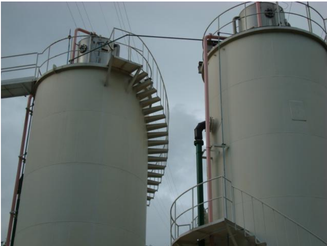
Figura 5. Reactor anaerobio PTAR Cervecería Bavaria Bucaramanga
