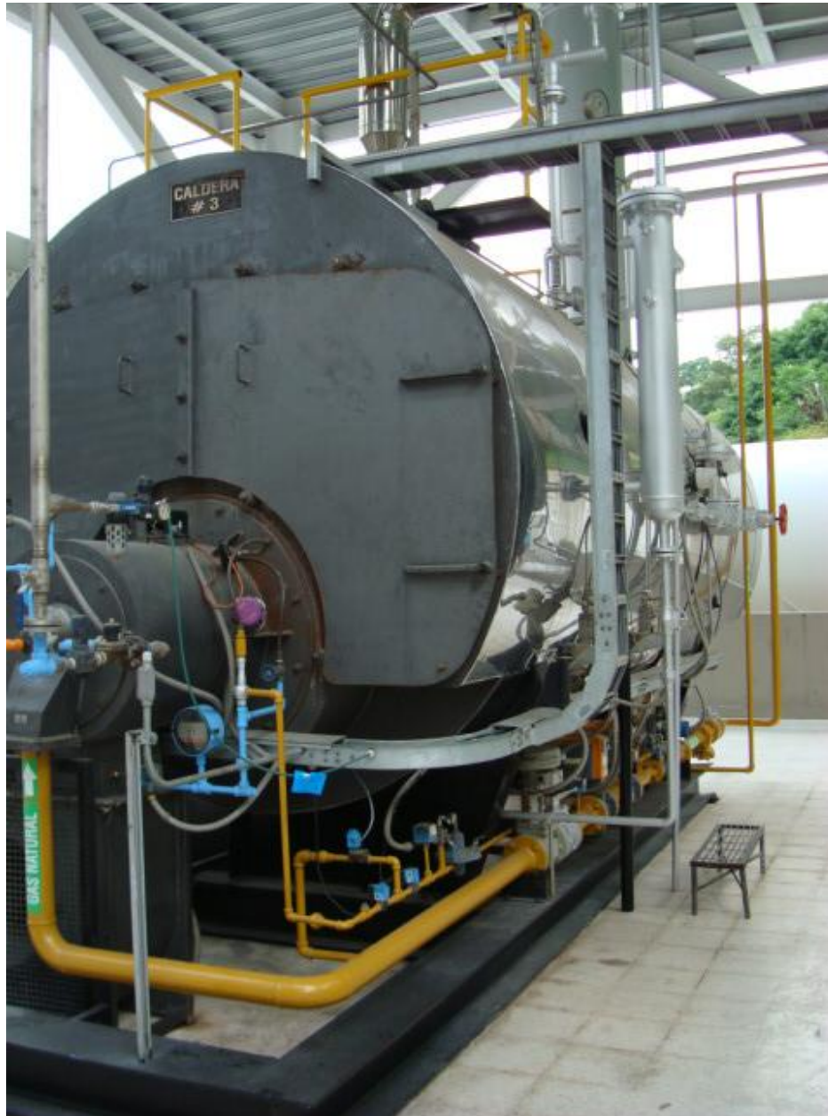
Figura 42. Caldera pirotubular
