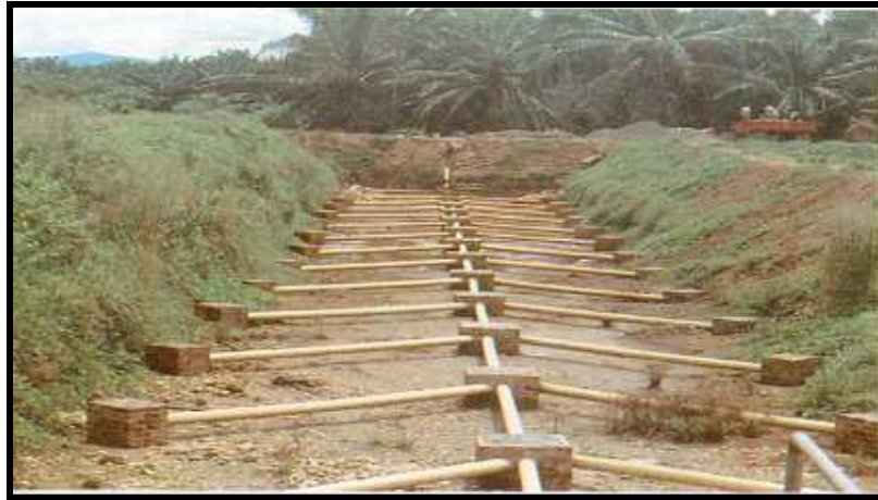
Figura No. 3. Sistema espina de pescado.
