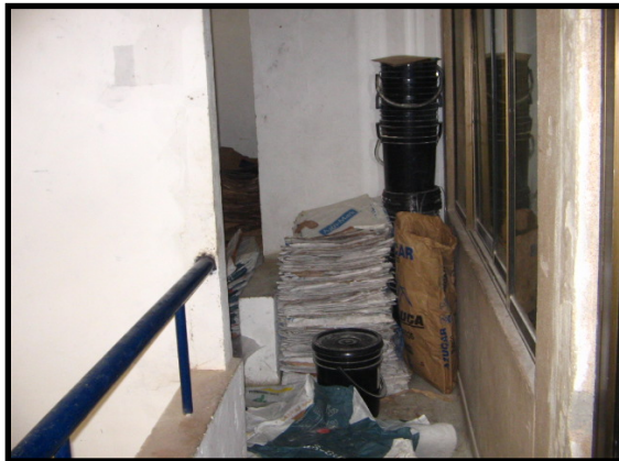
Pasillo de acceso al cuarto Reciclaje
