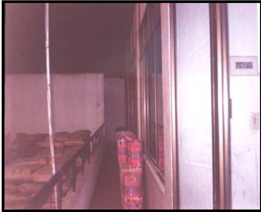
Pasillo de acceso al cuarto Reciclaje
