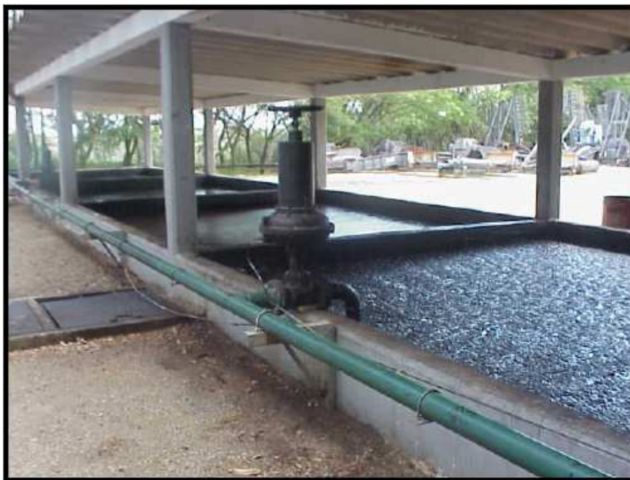
Figura 43. Lechos de secado.
