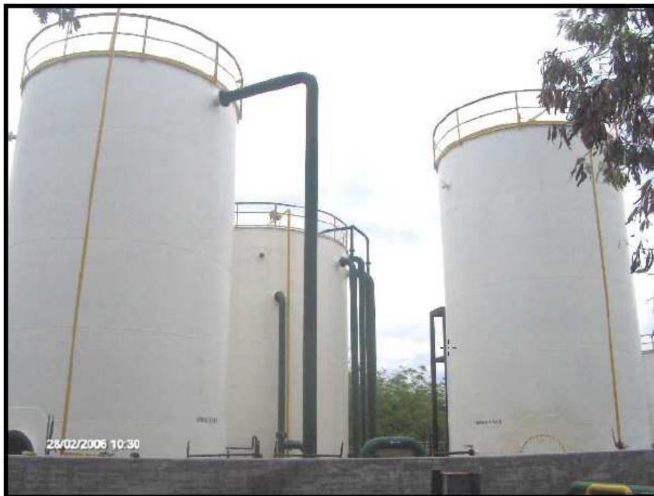
Figura 22. Tanques Desnatadores
