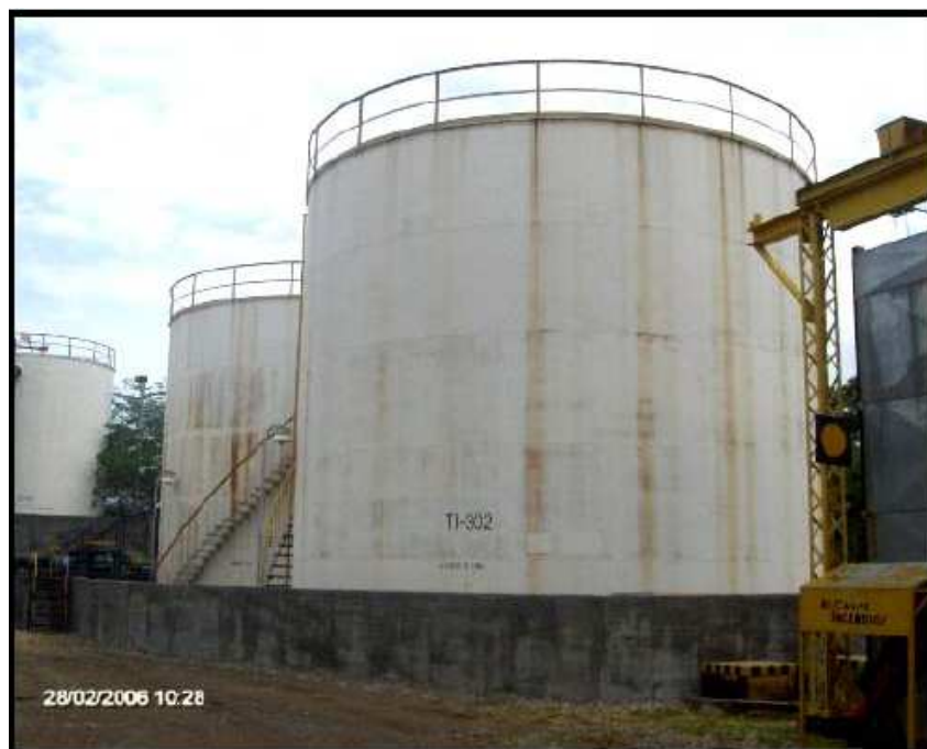
Figura 45. Tanques de Inyección
