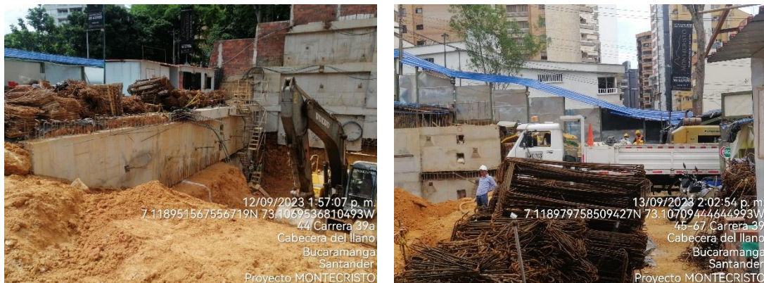
Almacenamiento de acero de refuerzo
