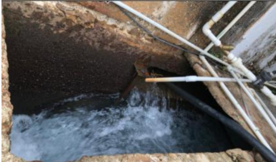
Fotografía 6. Inyección de cloro gaseoso
