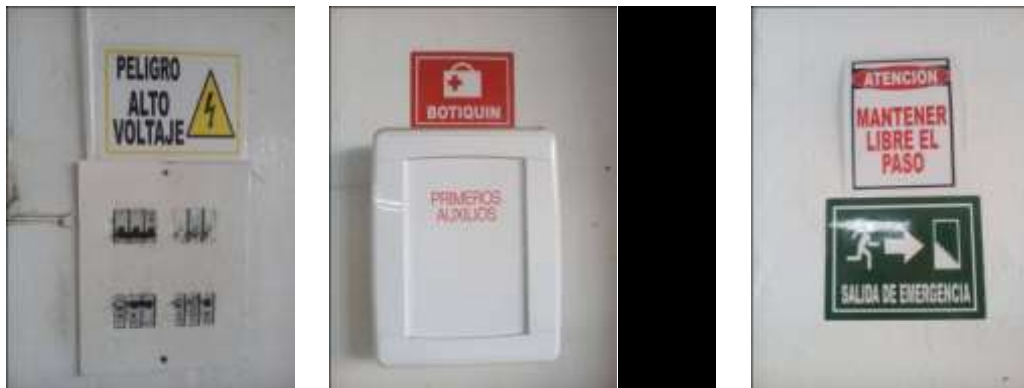
Ilustración 24. Evidencia 1, 2 y 3 de señalización
