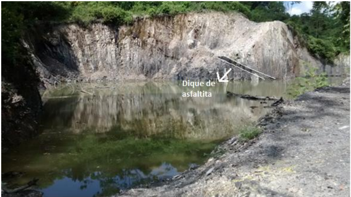
Figura 15. Mina Villa Rica sin licencia para ser explotado el material, donde se observa un dique de asfaltita.
