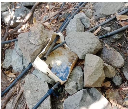
Figura 5: Obras del sistema en Vega de infantes
