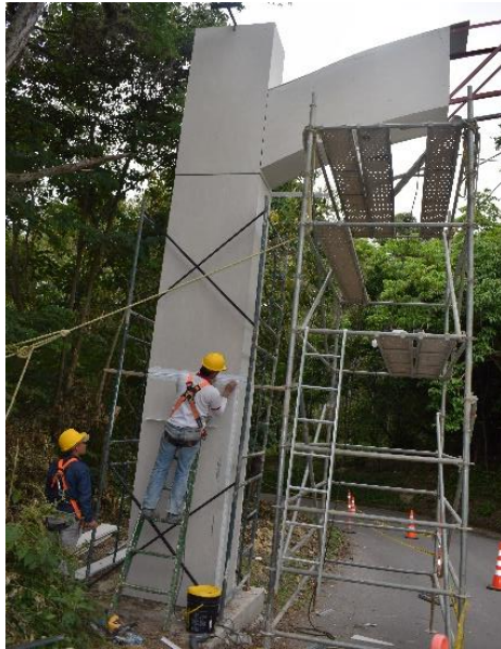
Figura 3. Supervisión de la obra del arco
