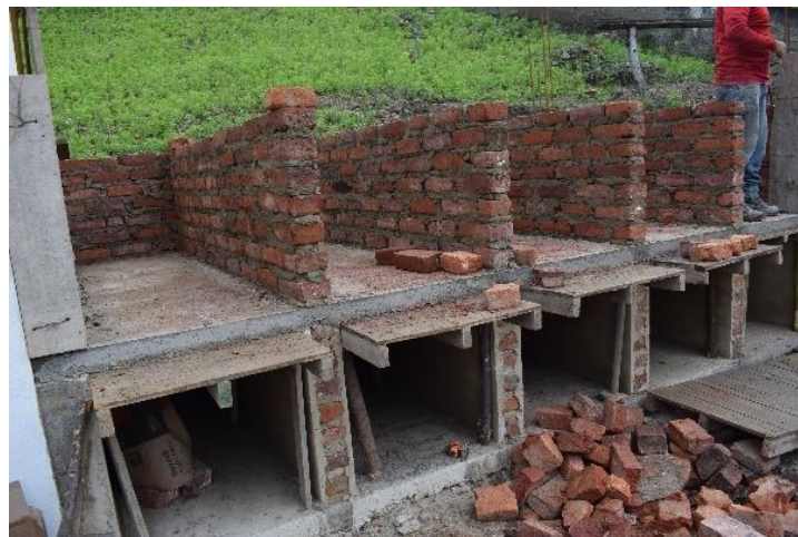
Figura 4. Supervisión de las bóvedas
