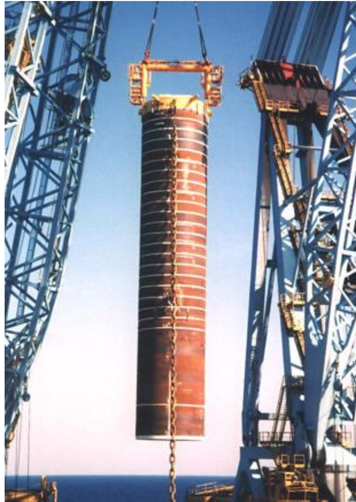
Figura 76. Instalación de un ancla de succión
