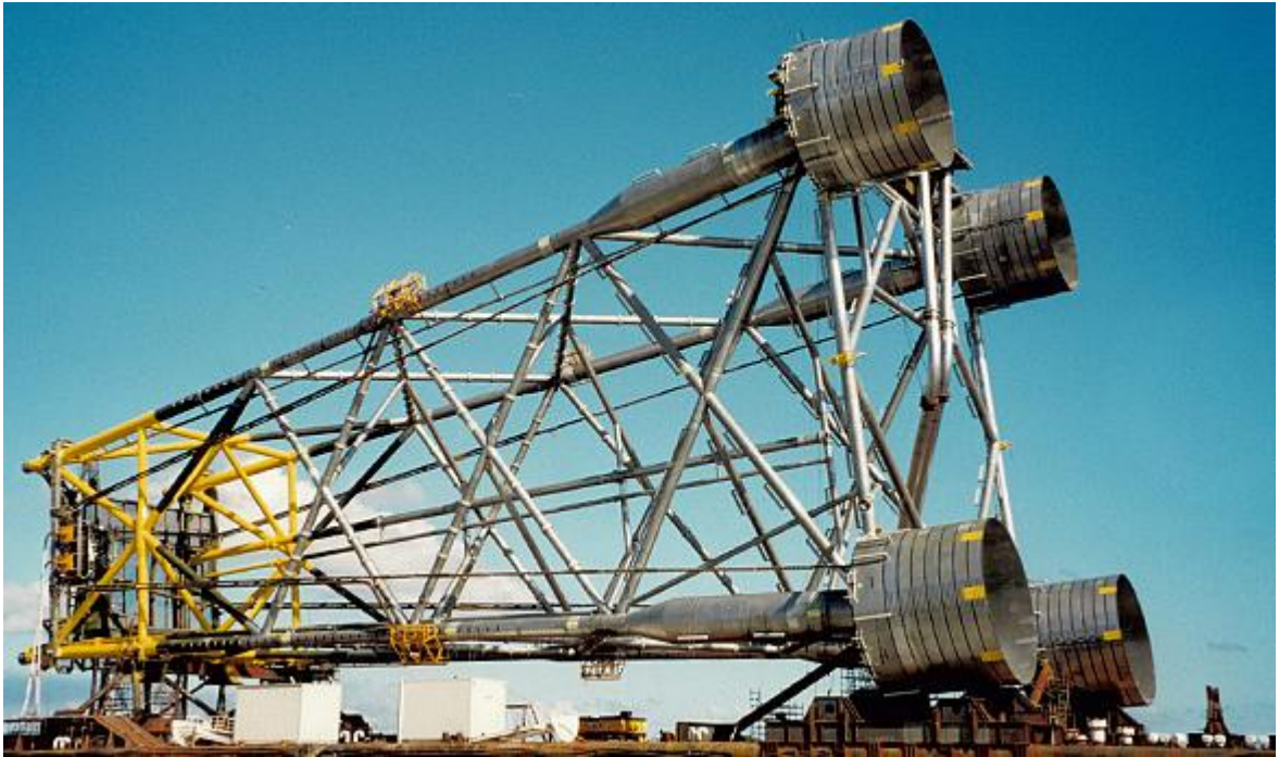
Figura 75. Anclas de succión en una plataforma jacket.
