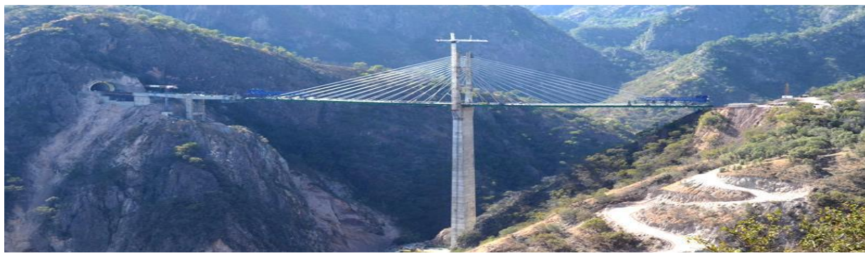
Figura 33. Puente el Carrizo. Adaptado de Crespo et.al, 2014). Plataforma para el análisis y visualización de señales para el monitoreo remoto de estructuras.
