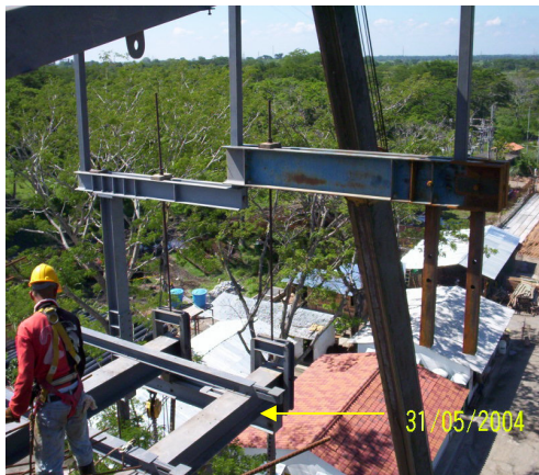
Figura 3.8 Apoyos de cerchas del carro de avance
