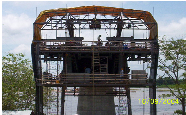
Figura 3.2 Vista frontal del carro de avance
