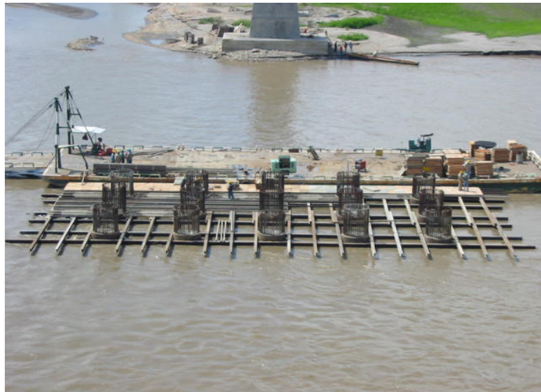
Figura 1.1 Obra falsa para la fundición de zapata.
