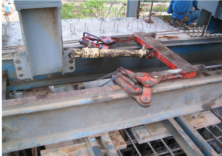
Figura 3.11 Avance del carro
