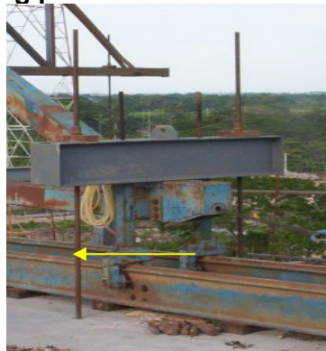
Figura 3.6 Barras dywidag para estructura del carro de avance
