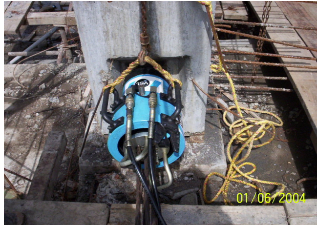
Figura 1.7. Tensionamiento de vigas con gato hidráulico.
