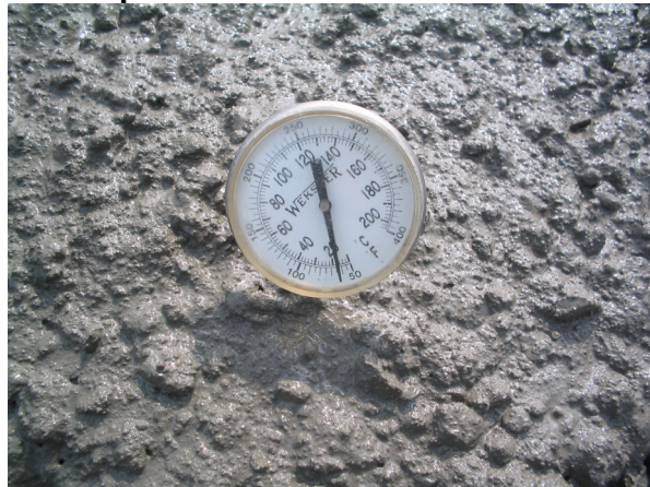
Figura 2.1 Toma de temperatura del concreto.
