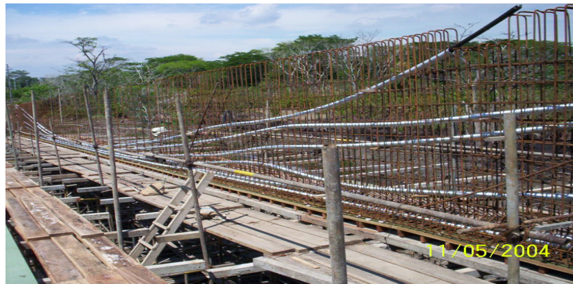
Figura 1.4. Cables para viga postensada
