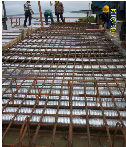
Figura 3.12 Ductos para cables
