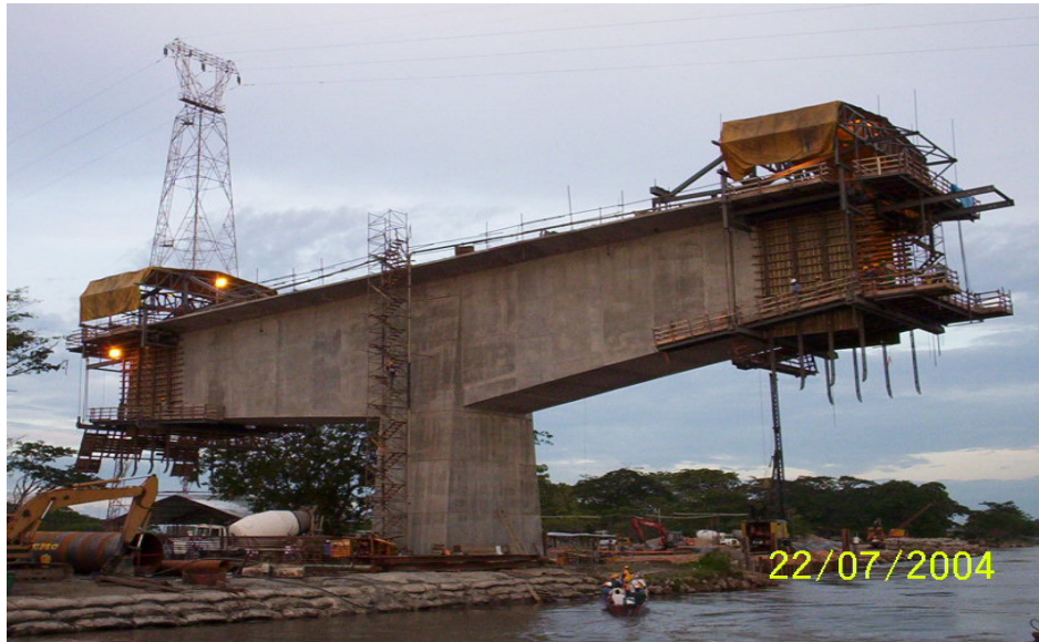
Figura 3.1 Sistema de voladizos sucesivos
