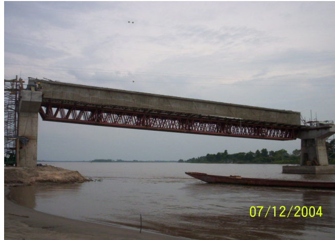
Figura 1.3 Cerchas de obra falsa para vigas postensadas.
