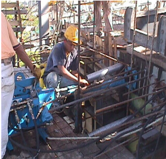
Figura 3.13 Enhebrado de torones
