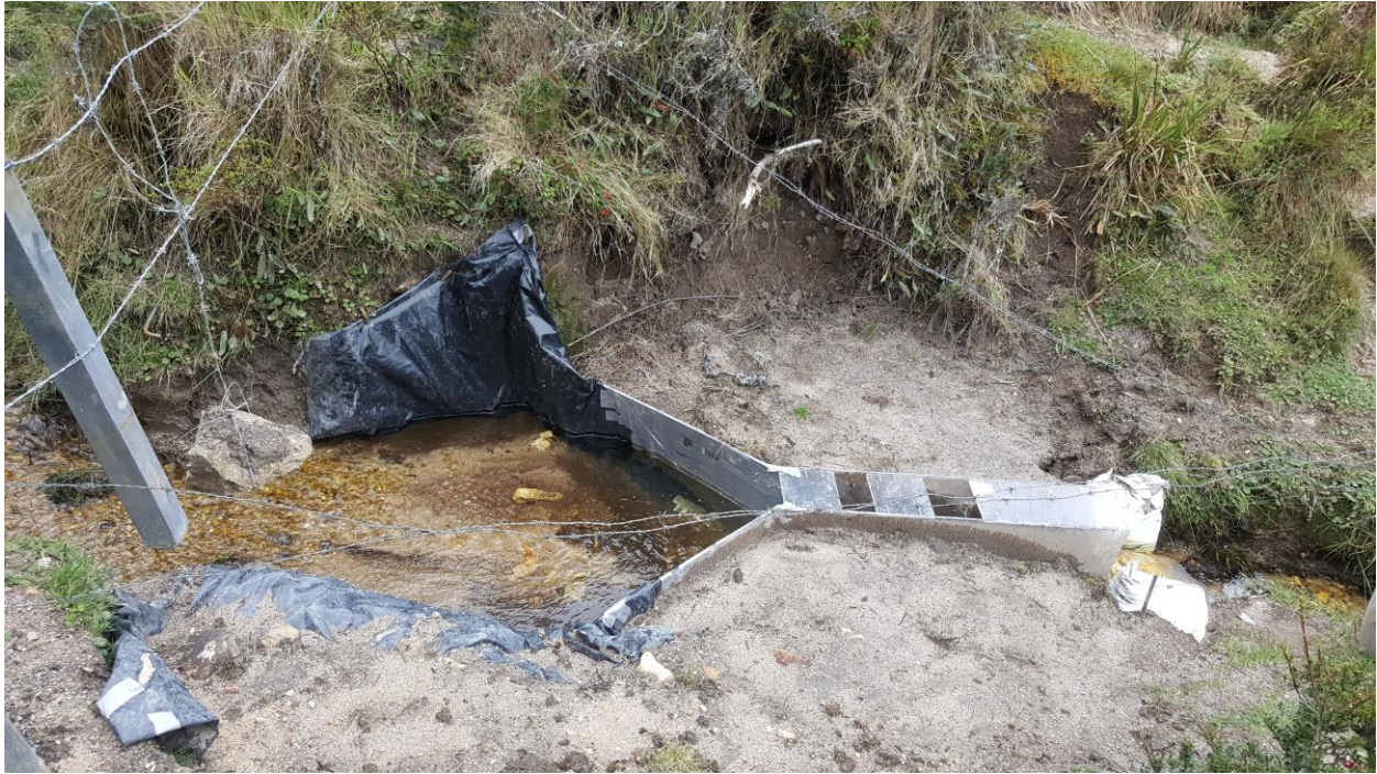
Foto A3. Instalación de la estructura de medición de caudal
