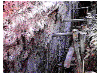
Excavación Apuntalada con Madera
