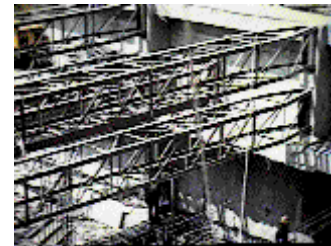
Excavación Apuntalada con Cercha Metálica
