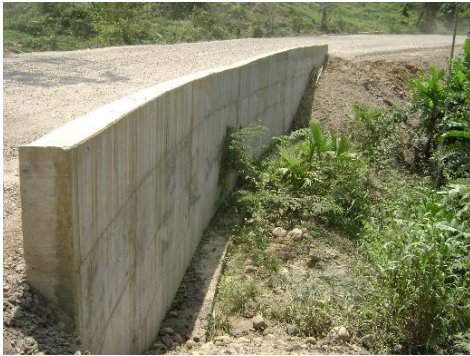
Figura 26. Muro Estructural (Yarima)
