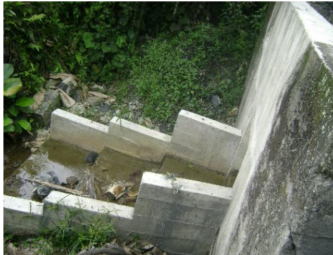
Figura 28. Estructura de Salida (Puente Nacional – Jesús María)
