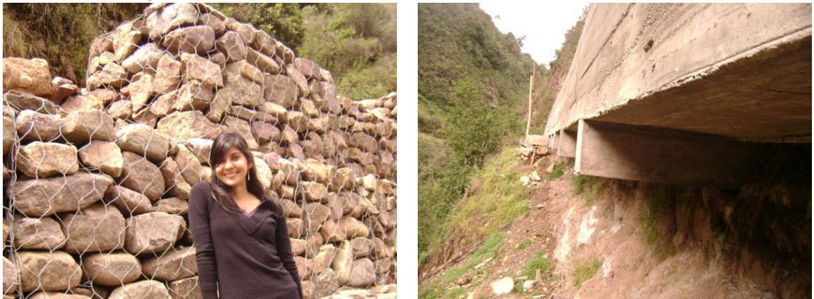
Figura 4. Visita de Obra – Elementos estructurales, Guaca
