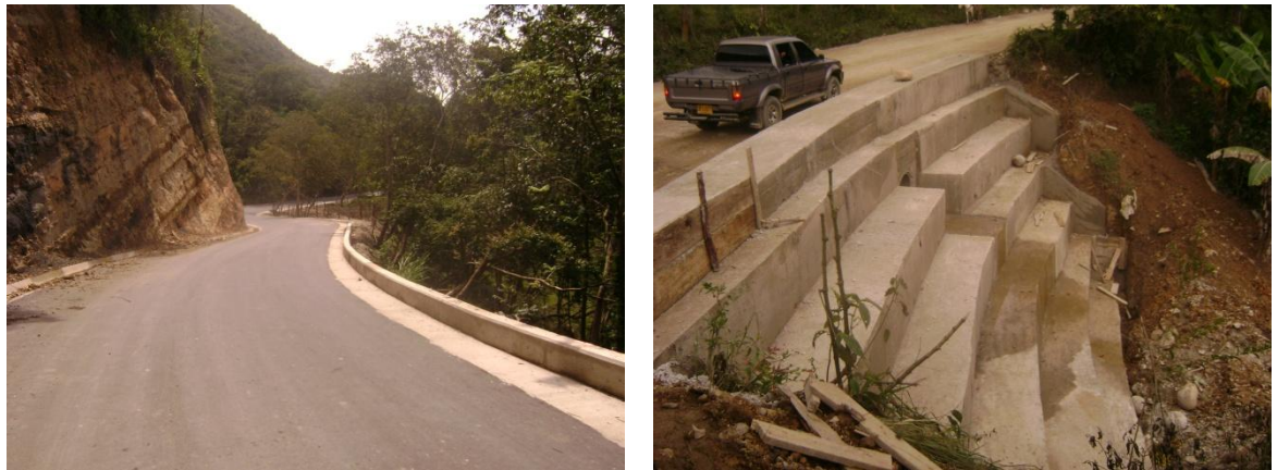
Figura 6. Visita de obra- Estado de la vía, Gambita
