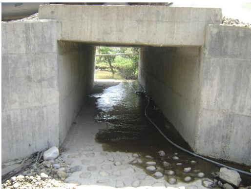
Figura 24. Box Culvert- Estructura de Entrada
