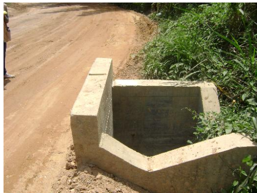
Figura 25. Alcantarilla - Estructura de Entrada
