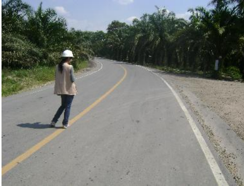
Figura 29. Inspección Visual del Pavimento
