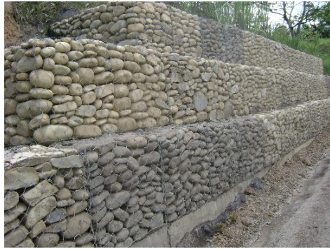
Figura 27. Muro en Gaviones (Suaita)
