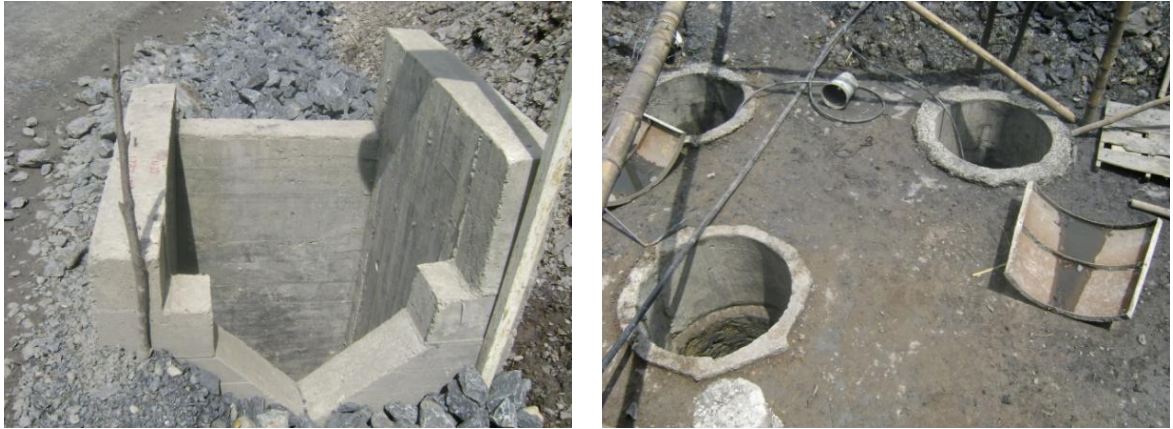
Figura 5. Visita de obra - Construcción de estructuras, Puente Nacional.
