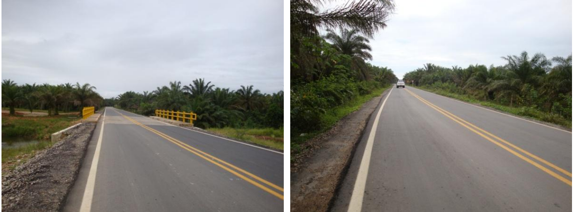
Figura 3. Visita de obra - Estado de la vía Pto. Wilches
