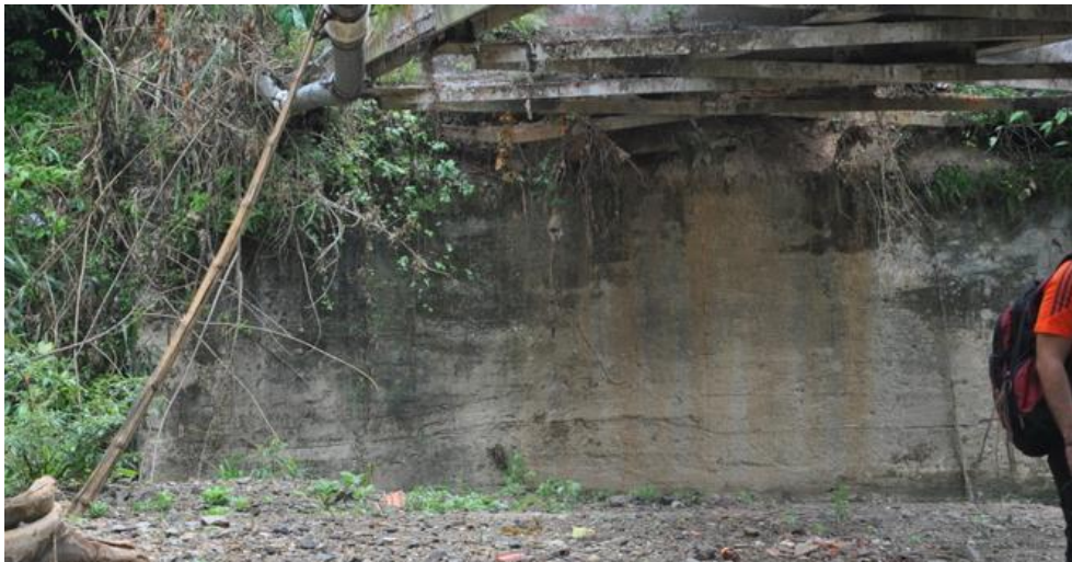
Figura 14. Estribo costado occidental. Fuente (Autores).Enero 2013
