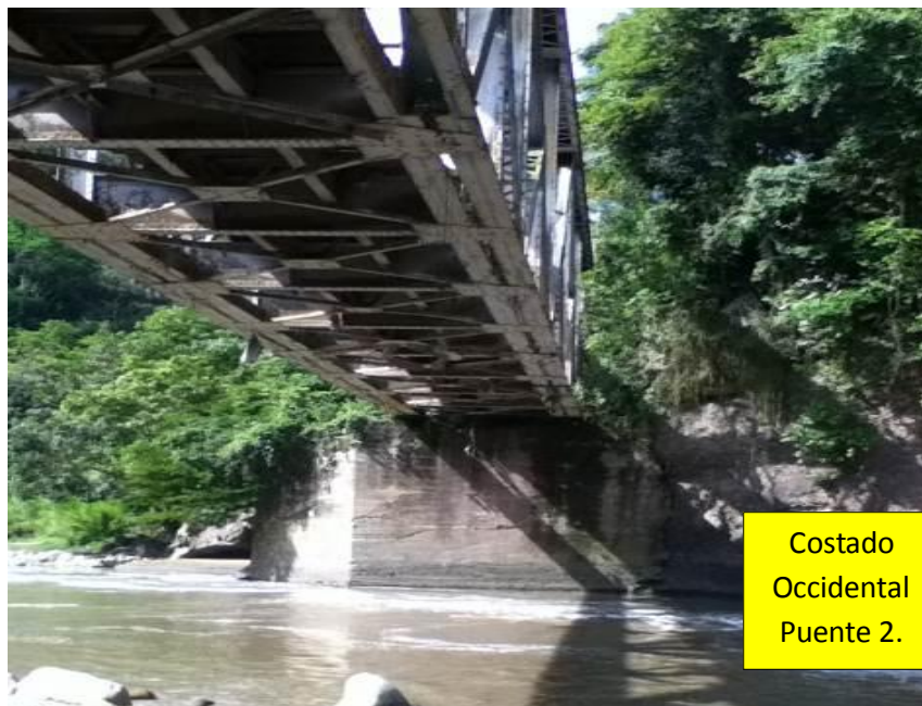
Figura 51. Estribo costado occidental. Fuente (Autores). Enero 2013
