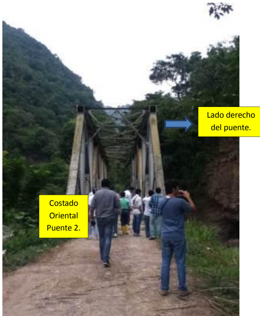
Figura 38. Acceso al puente 2. Fuente (Autores).Enero 2013
