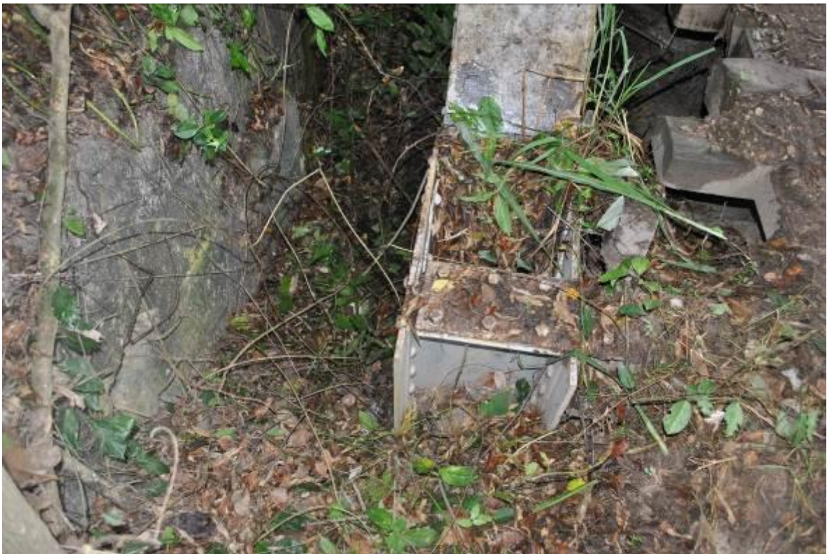
Figura 44. Apoyo derecho costado occidental. Fuente (Autores).Enero 2013
