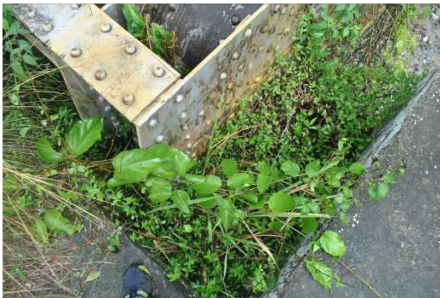
Figura 42. Apoyo derecho costado oriental. Fuente (Autores).Enero 2013
