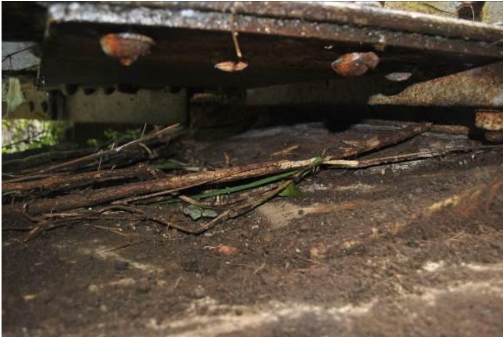
Figura 47. Apoyo Puente 2. Fuente (Autores).Enero 2013
