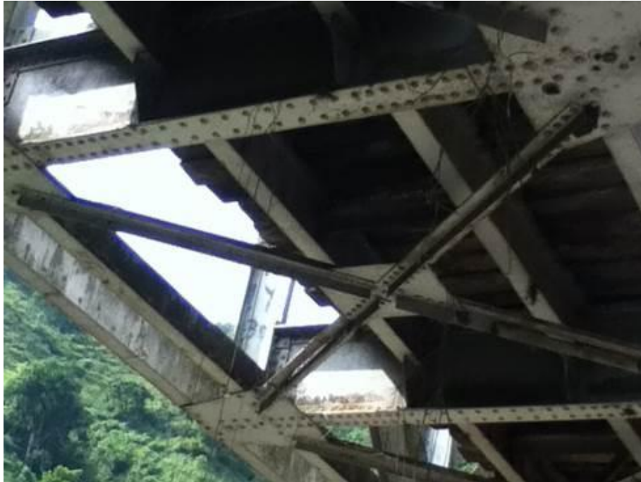
Figura 75. Elementos Transversales de grandes dimensiones y un riostrado inferior. Fuente (Autores).Enero 2013
