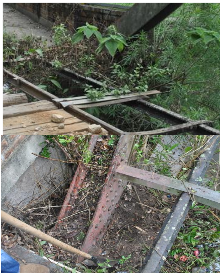
Figura 10. Apoyo derecho costado occidental. Fuente (Autores).Enero 2013
