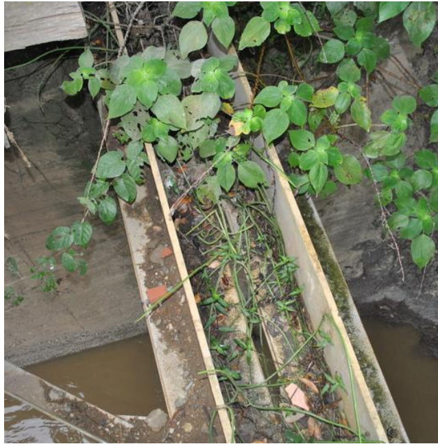
Figura 76. Perfil del cordón inferior de la armadura en la parte central del puente. Fuente (Autores).Enero 2013
