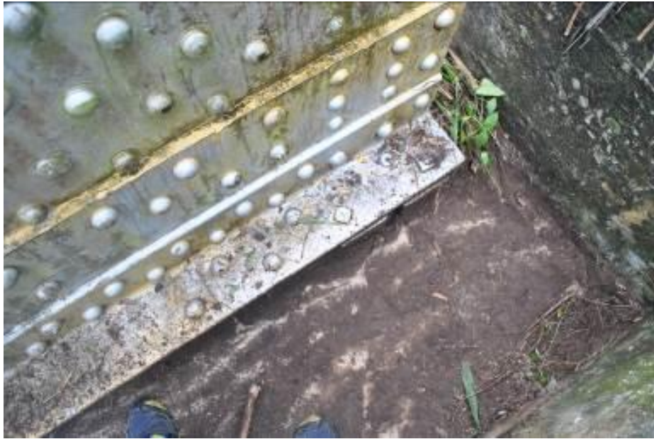
Figura 45. Apoyo izquierdo costado oriental. Fuente (Autores).Enero 2013
