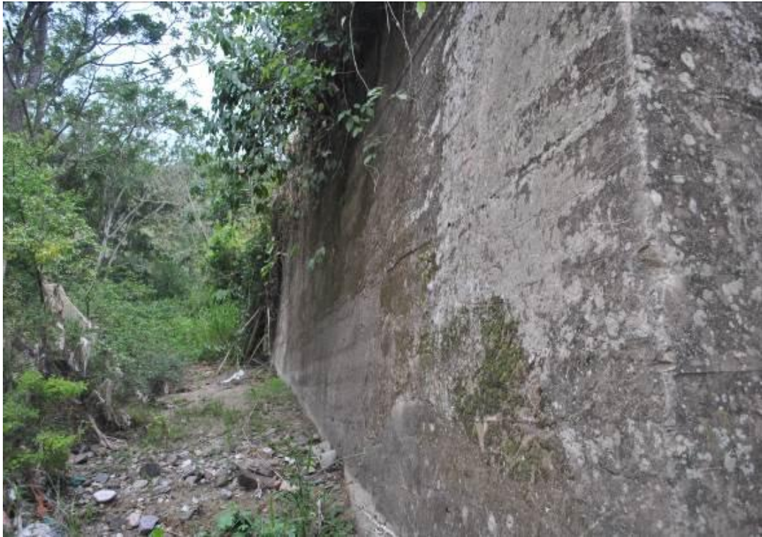
Figura 54. Muro de retorno estribo costado oriental. Fuente (Autores).Enero 2013
