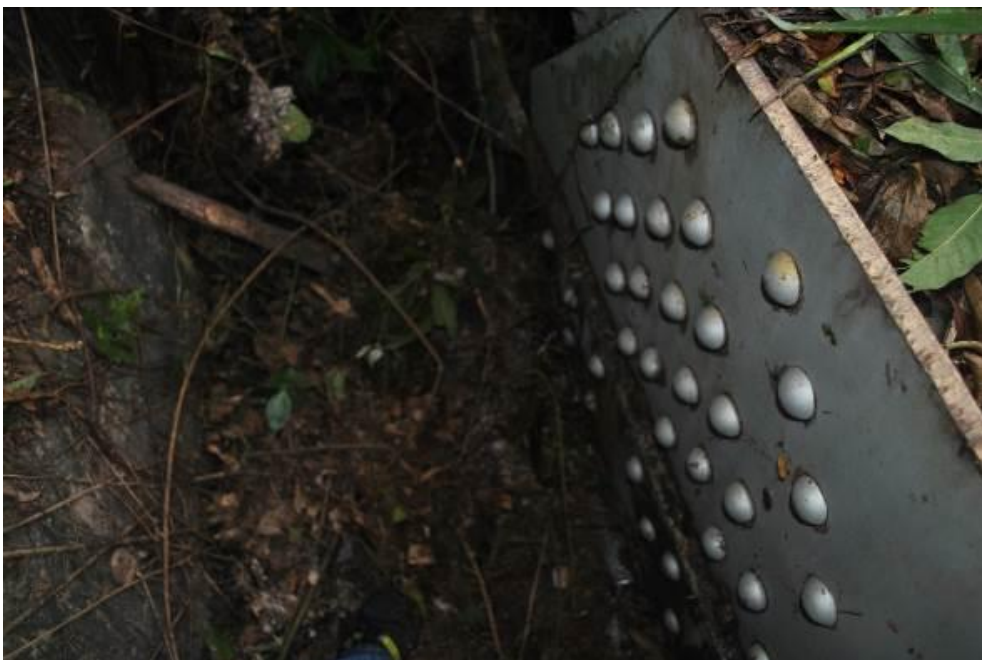
Figura 48. Conexión apoyo puente 2. Fuente (Autores).Enero 2013
