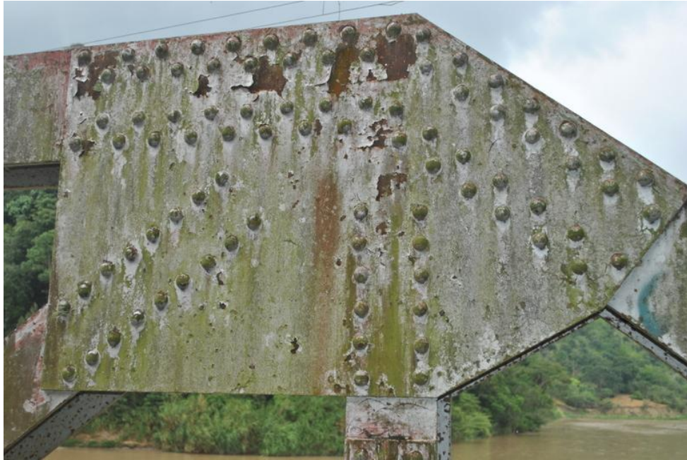
Figura 20. Conexiones típicas con remaches. Fuente (Autores).Enero 2013
