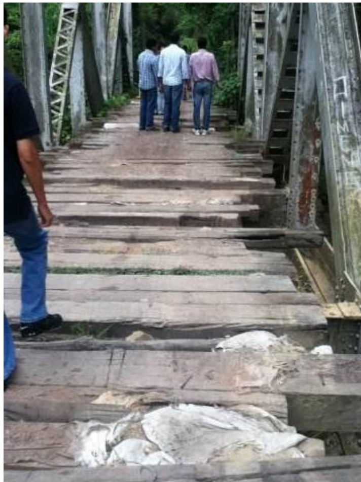
Figura 40. Tablones que hacen la vez de tablero. Fuente (Autores).Enero 2013
