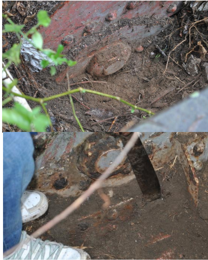
Figura 11. Apoyo izquierdo costado oriental. Fuente (Autores).Enero 2013
