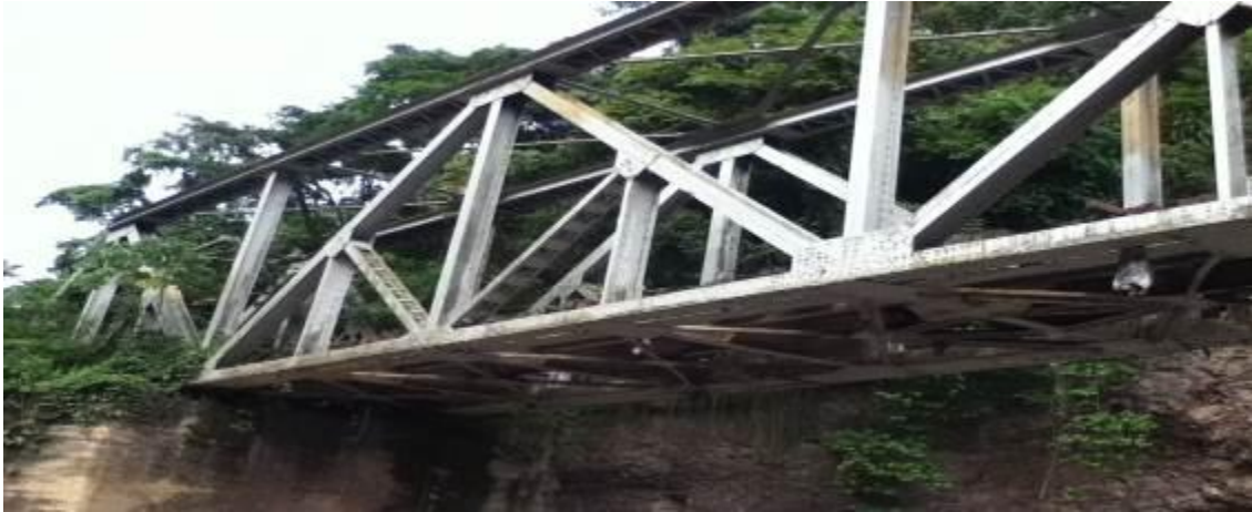
Figura 73. Riostrado Inferior. Fuente (Autores).Enero 2013
