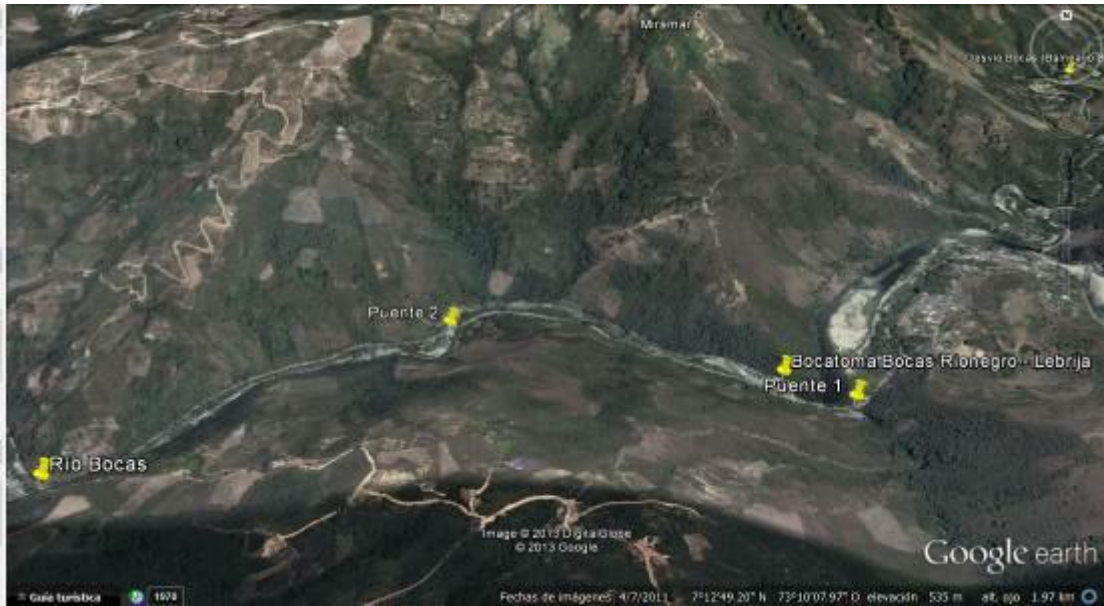
Figura 3. Ubicación geográfica puente 1 y puente 2. Fuente Google earth. Enero 2013
