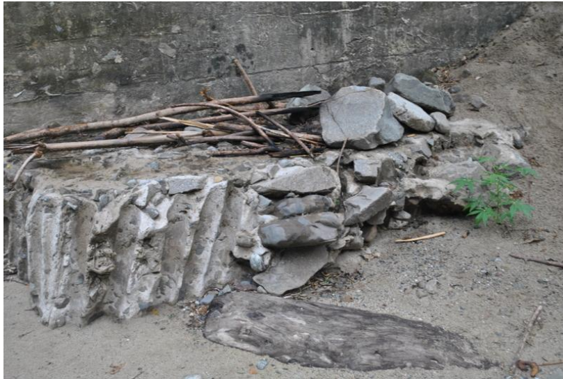
Figura 68. Cimentación descubierta. Estribo costado oriental. Fuente (Autores).Enero 2013
