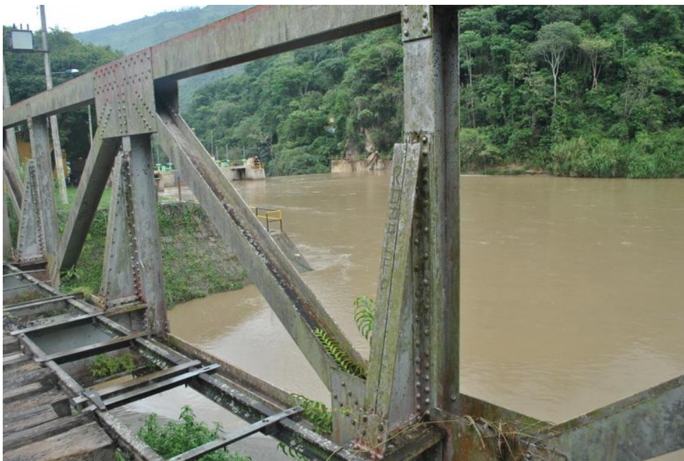
Figura 21. Armadura lateral tipo Warren. Fuente (Autores).Enero 2013
