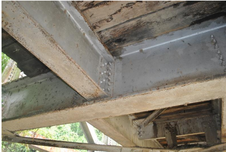
Figura 22. Elementos Transversales de grandes dimensiones y un riostrado inferior. Fuente (Autores).Enero 2013
