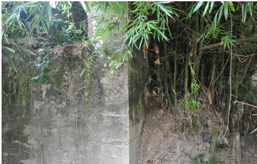
Figura 18.Unión entre pantalla y muro de retorno izquierdo en el estribo costado oriental. Fuente (Autores).Enero 2013
