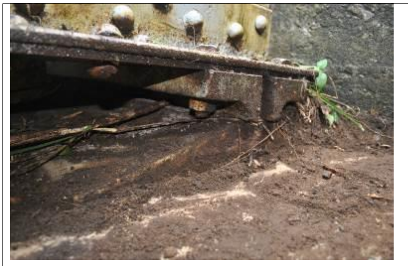
Figura 122. Apoyo puente 2. Fuente (Autores).
