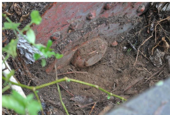
Figura 114. Condición de apoyo puente 1. Fuente (Autores).
