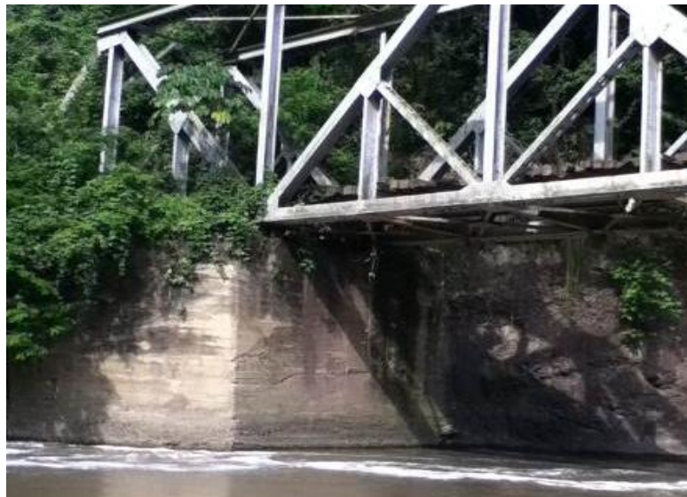
Figura 50. Estribo costado occidental. Fuente (Autores). Enero 2013
