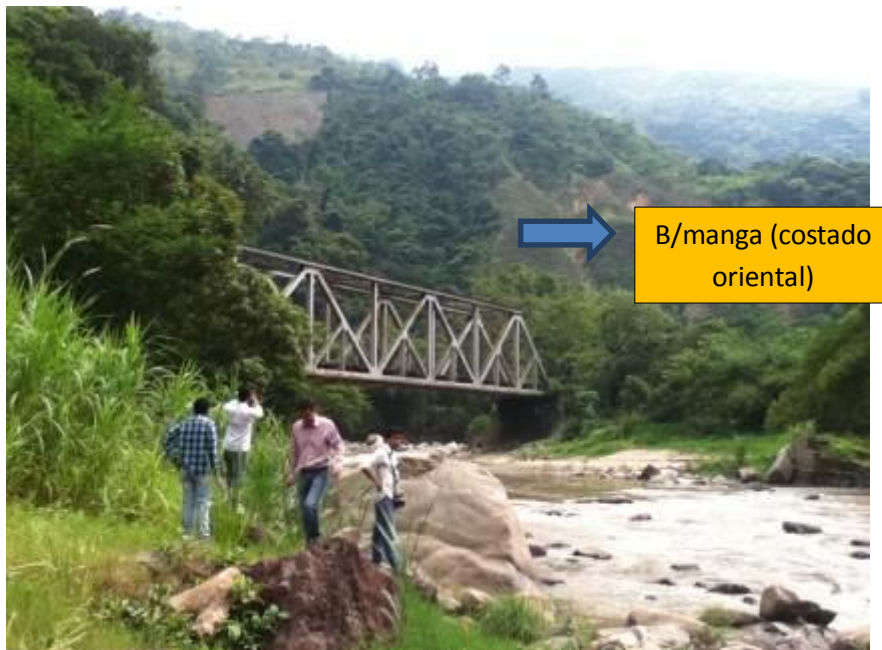
Figura 39. Vista general puente 2. Fuente (Autores).Enero 2013
