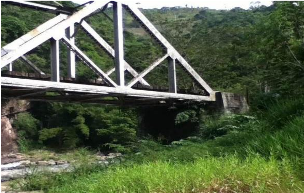
Figura 52. .Estribo costado oriental puente 2. Fuente (Autores).Enero 2013
