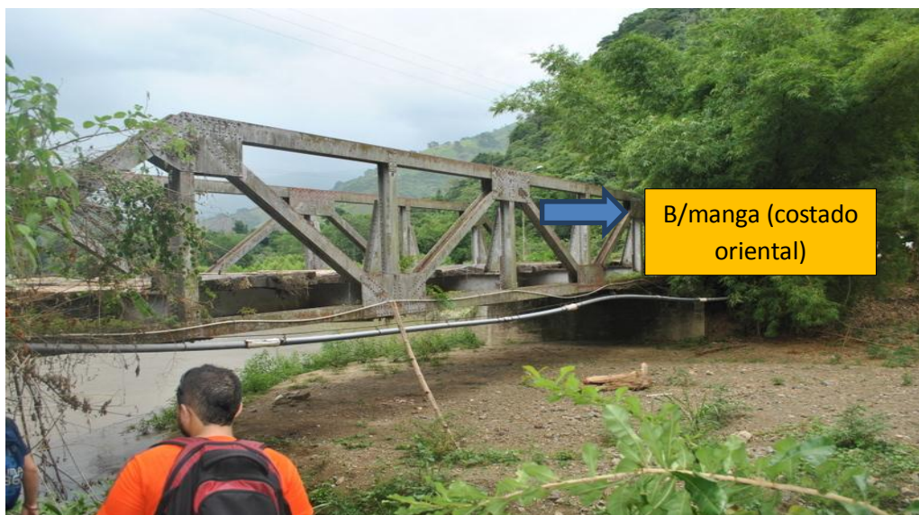
Figura 8. Vista general puente 1. Fuente (Autores). Enero 2013
