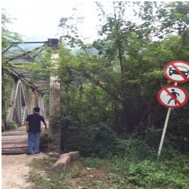
Figura 37. Señalización. Costado Occidental puente 2. Fuente (Autores).Enero 2013
