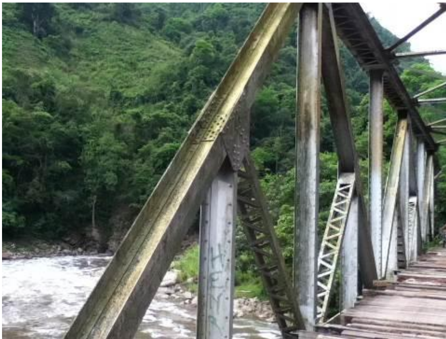
Figura 74. Armadura lateral tipo Baltimore. Fuente (Autores).Enero 2013
