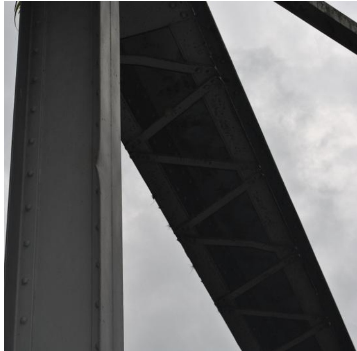
Figura 78. Cordón superior de la armadura. Fuente (Autores).Enero 2013
