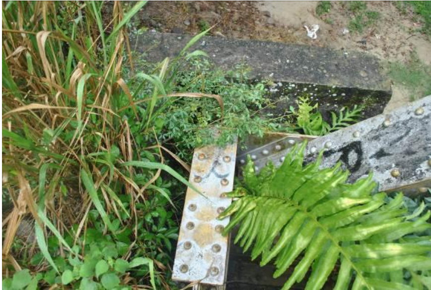
Figura 41. Apoyo izquierdo costado oriental. Fuente (Autores).Enero 2013
