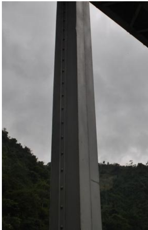
Figura 81. Montante cercha puente 2. Fuente (Autores).Enero 2013
