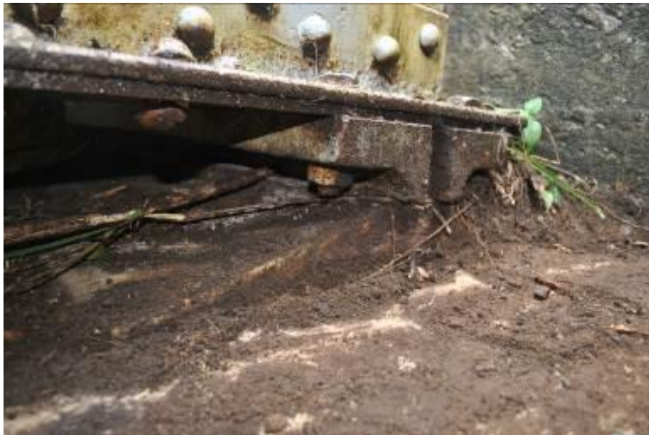
Figura 46. Apoyo izquierdo costado oriental. Fuente (Autores).Enero 2013
