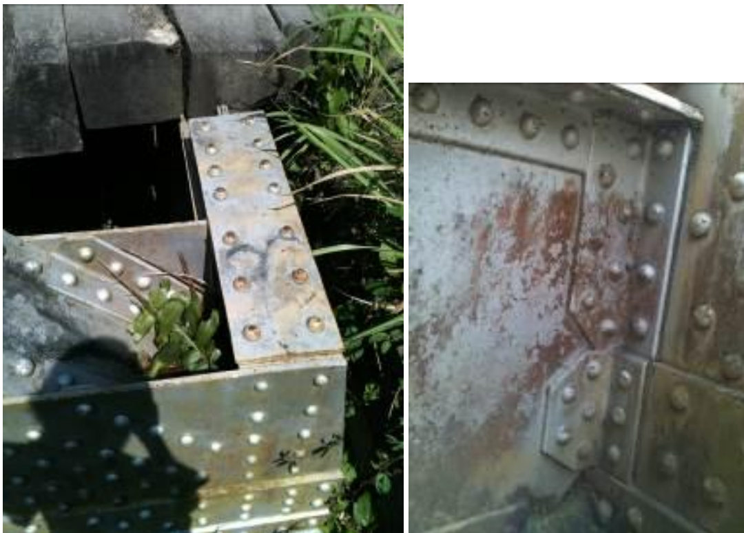
Figura 72. Conexiones típicas con remaches. Fuente (Autores).Enero 2013
