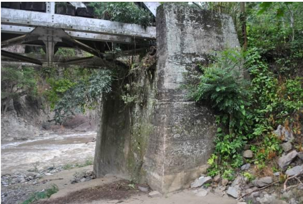
Figura 53. Estribo costado oriental puente 2. Fuente (Autores).Enero 2013
