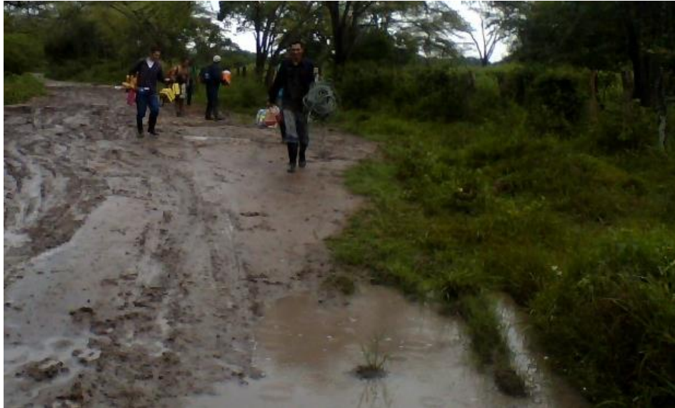
Figura 1. Evidencia del deterioro de la vía.
