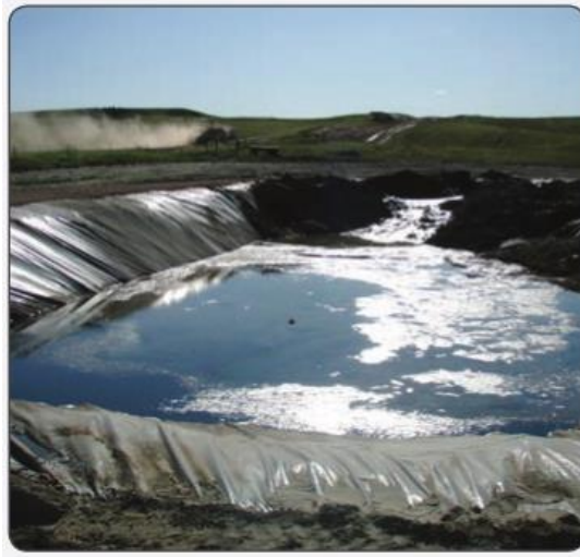
Figura 14. Depósito de lodos residuales” en un sitio de perforación de gas de lutitas en Bakken, EE.UU.
