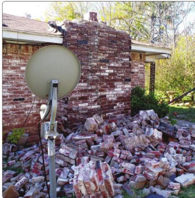
Figura 9. Daños producidos en una residencia por un terremoto de magnitud 5.7, que afectó a Praga, Oklahoma en 2011.
