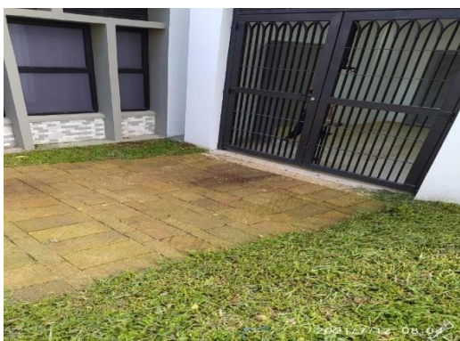
Salida de emergencia de Edificio Administrativo 1.
