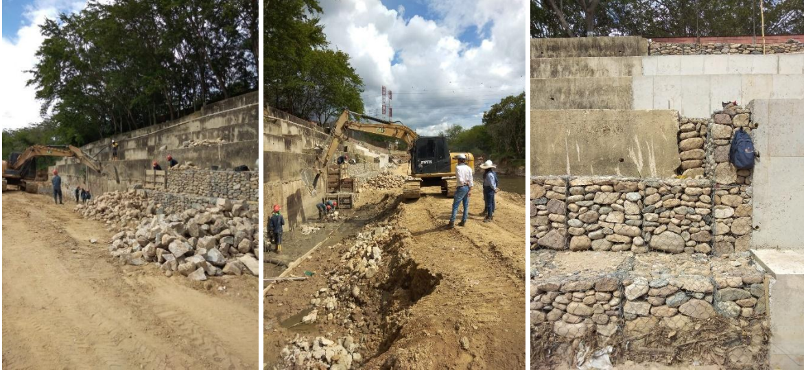
Fotografías 21, 22 y 23. Tercer frente de obra. Fuente: Propia.
