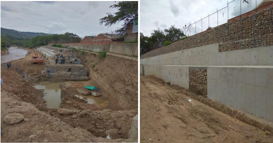
Fotografías 30 y 31. Segundo frente de obra. Fuente: Propia.
