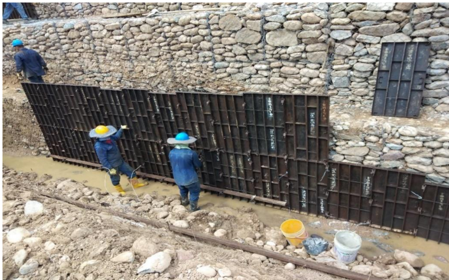
Fotografía 16. Suministro y colocación de concreto de 3000 psi para el recubrimiento. Fuente: Propia.
