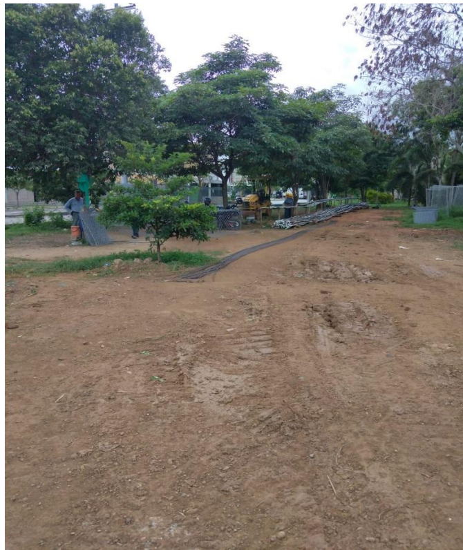
Fotografía 24. Campamento al interior de Centroabastos. Fuente: Propia.
