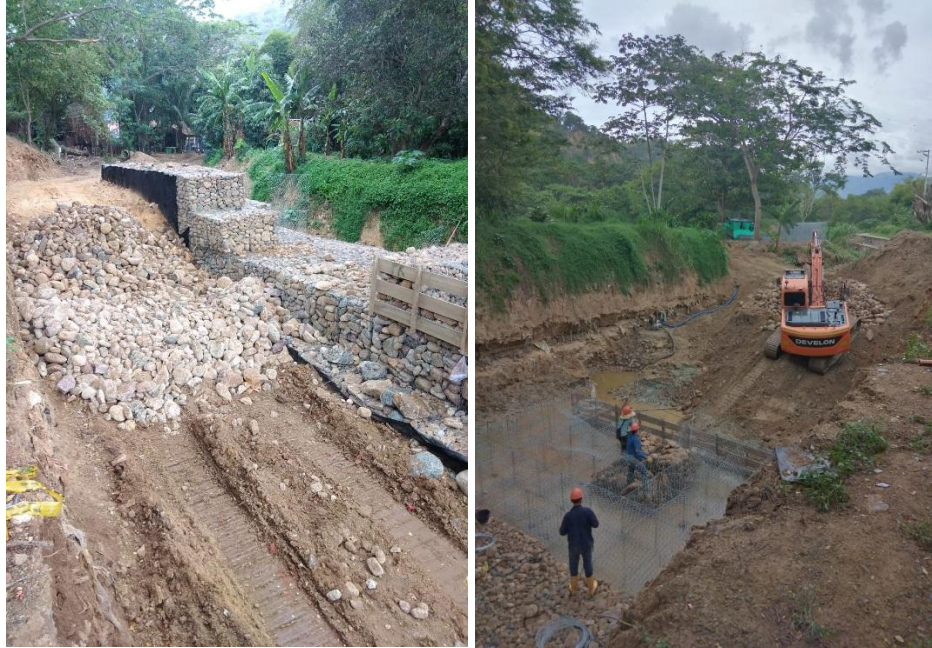
Fotografías 26 y 27. Avance en el primer frente de obra. Fuente: Propia.
