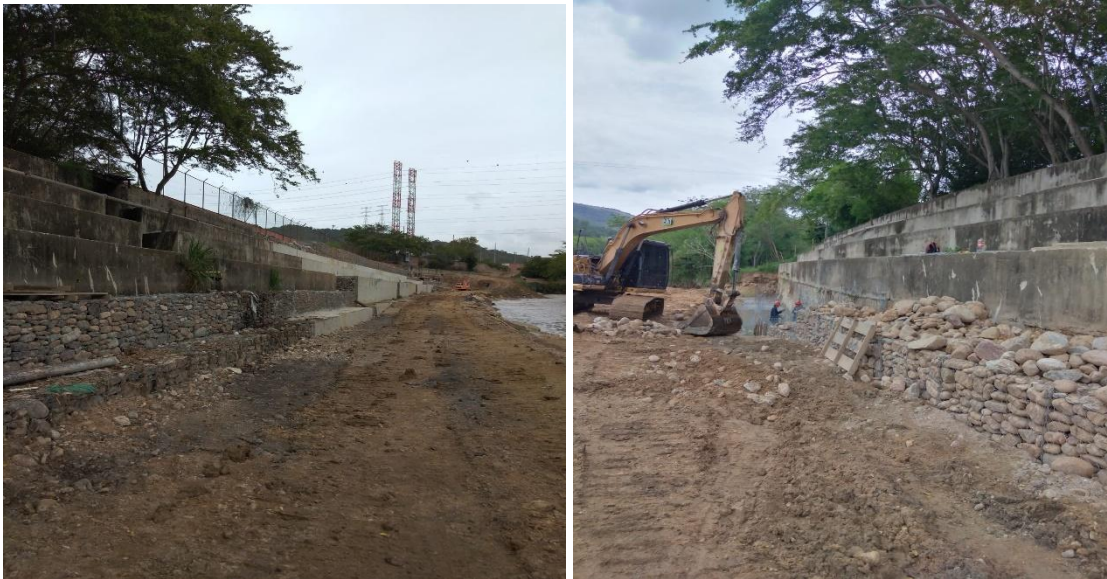
Fotografías 34 y 35. Tercer frente de obra. Fuente: Propia.
