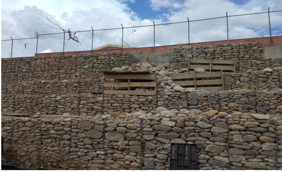
Fotografía 17. Armado de los gaviones con malla triple torsión, de cuerpo 2.00 x 1.00 x 1.00 y la instalación de los lloraderos Fuente: Propia.
