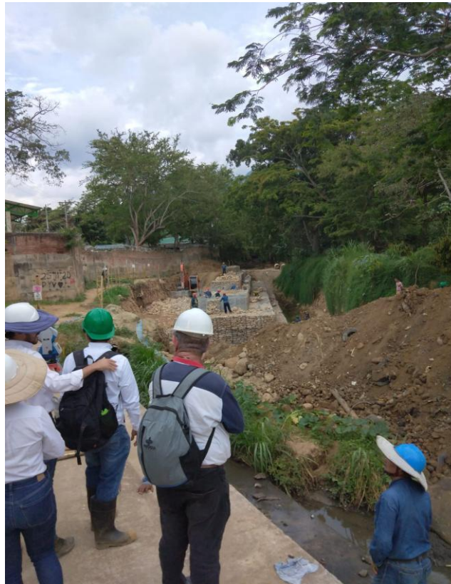
Fotografía 36. Primer frente de obra. Fuente: Propia.
