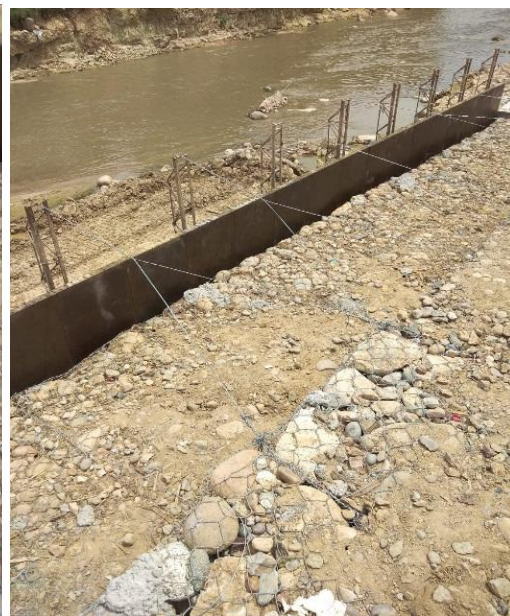
Fotografías 42 y 43. Armado de la formaleta y agregado grueso de menor tamaño para reducir la porosidad. Fuente: Propia.
