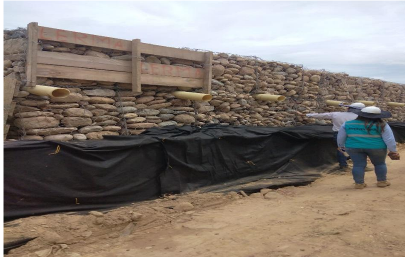
Fotografía 41. Aberturas para la instalación de los anclajes. Fuente: Propia.
