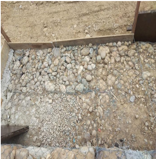
Fotografías 42 y 43. Armado de la formaleta y agregado grueso de menor tamaño para reducir la porosidad. Fuente: Propia.
