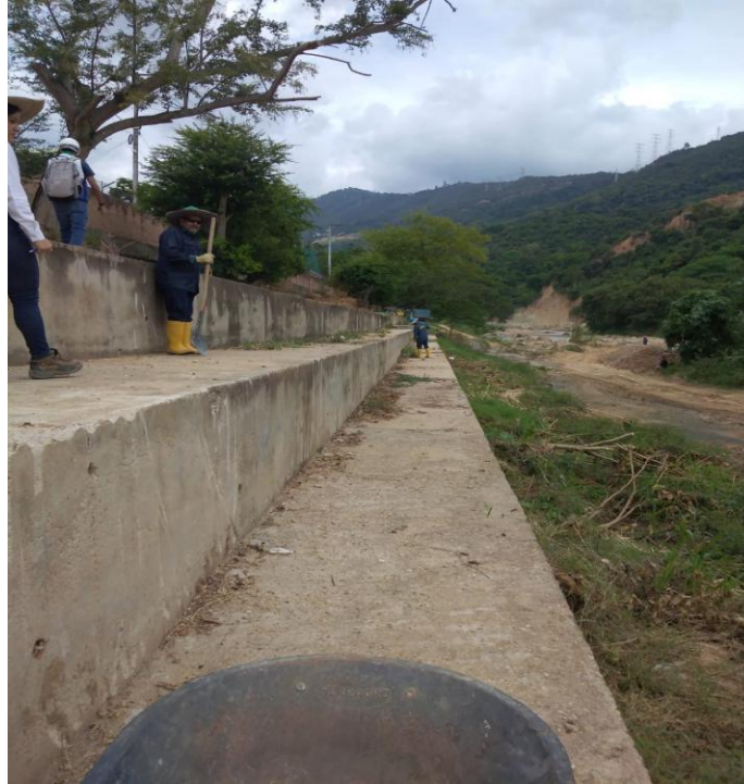
Fotografía 46. Desmonte y limpieza de la cobertura vegetal. Fuente: Propia.
