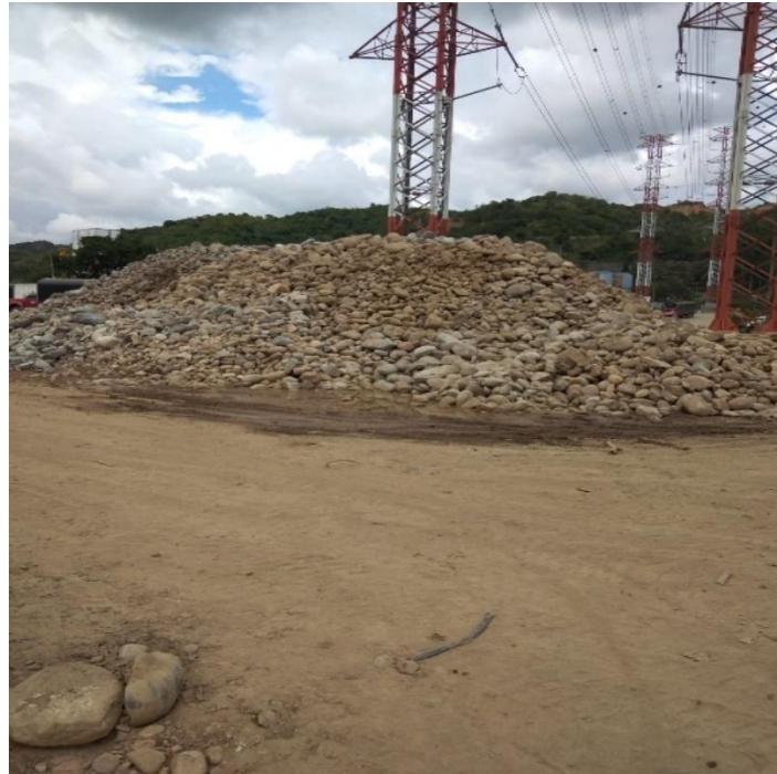
Fotografía 5. Suministro de agregado grueso. Fuente: Propia.
