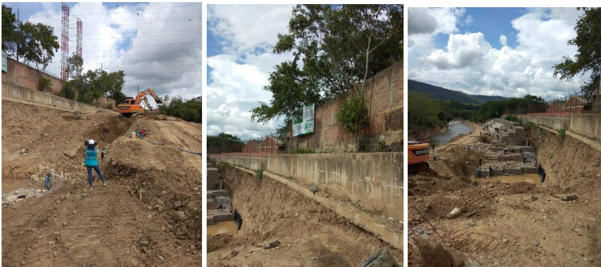
Fotografías 12, 13 y 14. Segundo frente de obra. Fuente: Propia.
