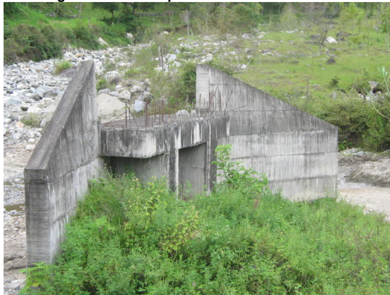
Figura. Estribo del puente en el sitio “El Roble”.
