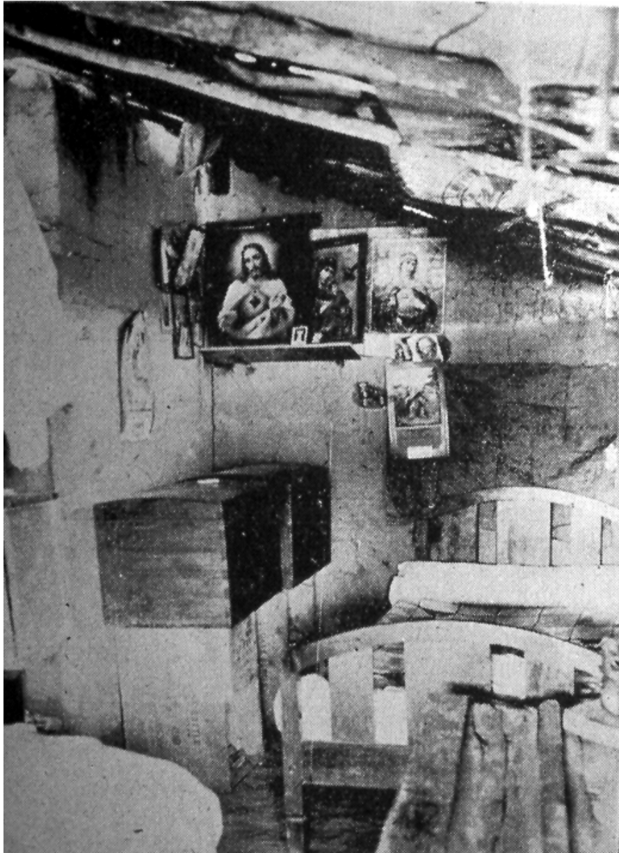
Fig. 7 Fotografía condiciones de vivienda obrera de Bucaramanga Fuente: Censo de población obrera Bucaramanga DANE 1942
