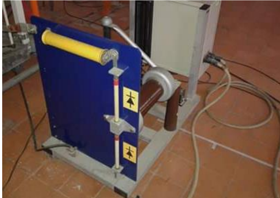
Figura 4. Unidad de carga del generador laboratorio UIS.
