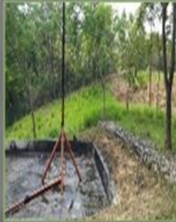
Dique impermeabilizado tea de la Batería Toy
