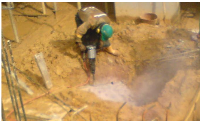
Figura N°9 Perforación de la roca para la aplicación del cras.
