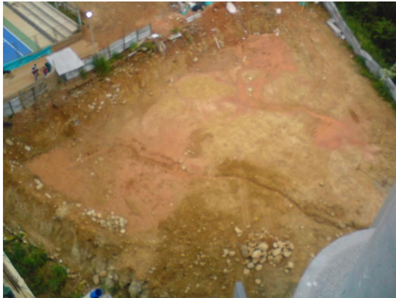
Figura N°8 Terreno en condiciones para iniciar el proyecto
