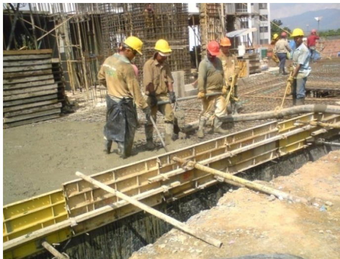
Figura N°21 Fundida Placa Piso1Fase II.
