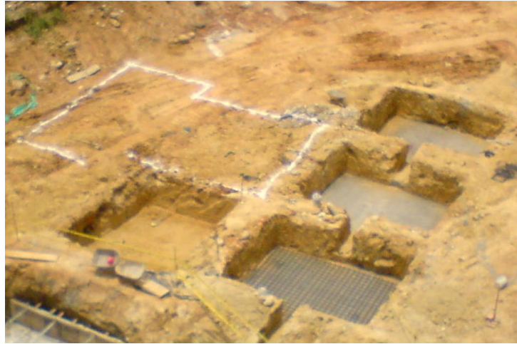
Figura N°12 Zapatas Cimentación
