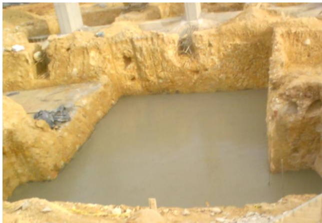
Figura N°11 Solado foso Ascensor
