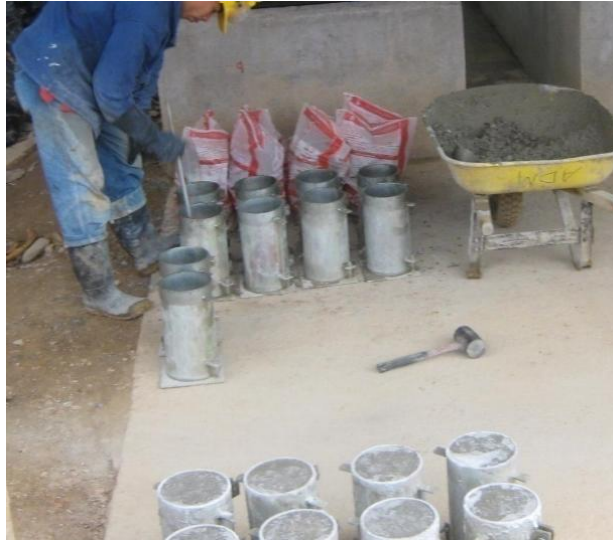
Figura N°3 Elaboración de Cilindros de concreto.
