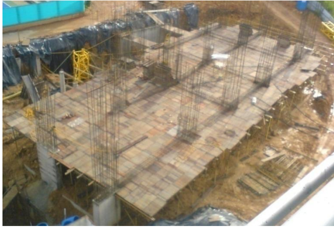
Figura N°18 Armada Acero de Refuerzo Placa Piso 1
