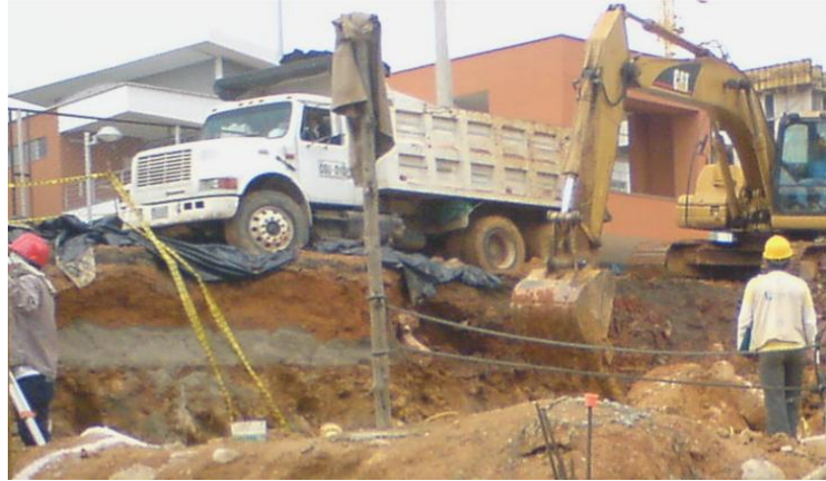
Figura N°26 Movimiento de Tierra Muro de Contención
