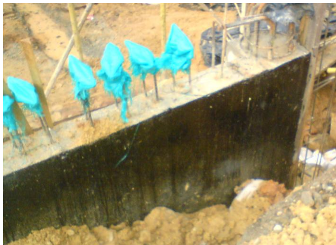
Figura N°29 Impermeabilización y muro de contención
