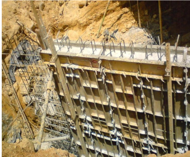
Figura N°28 Fundida Muro de Contención
