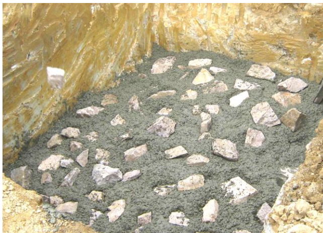
Figura N°10 Pila en concreto ciclópeo
