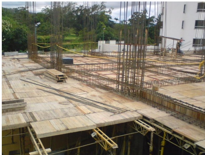
Figura N°19 Armada Acero de Refuerzo Placa Piso 1 Torre 3.
