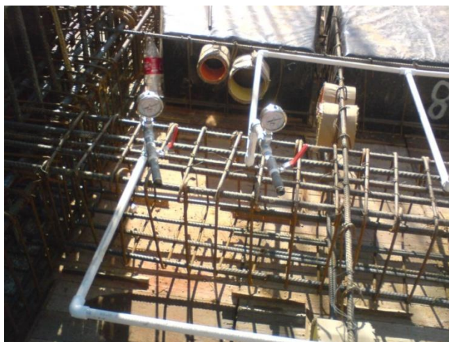
Figura N°30 Prueba Hidrostática de Presión
