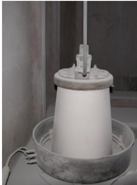
Foto 17. Desgaste en bujes eje sistema martilleo placas colectoras
