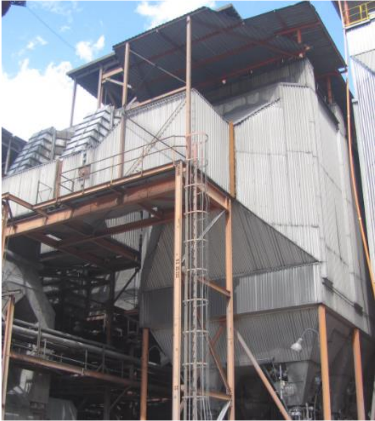
Foto 2. Precipitador electrostático cámara A unidad 2
