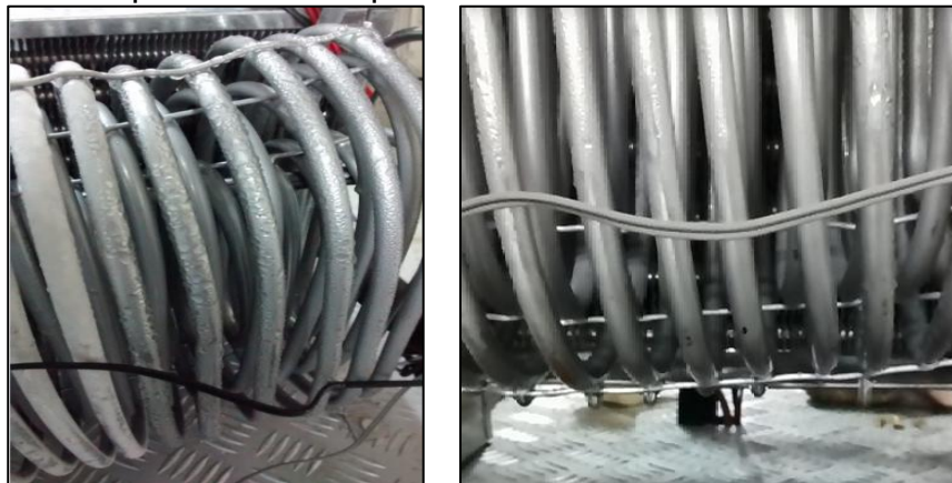
Figura 82. Prueba piloto en el evaporador.
