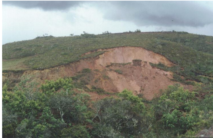
Figura 2. Deslizamiento rotacional. Armenia, Quindío.
