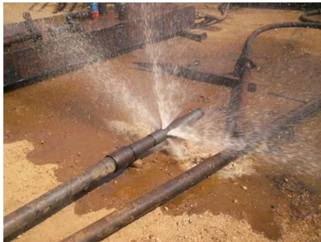
Figura 3. Auto Flow Valve con Bomba detenida
